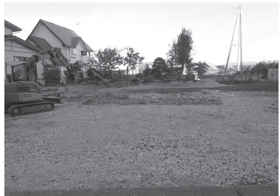
西屋敷地内調査前状況（西より）
