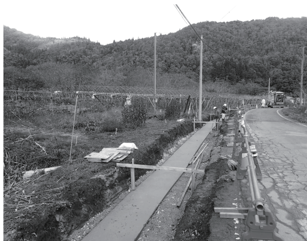
岩屋堂遺跡立会調査（南より）
