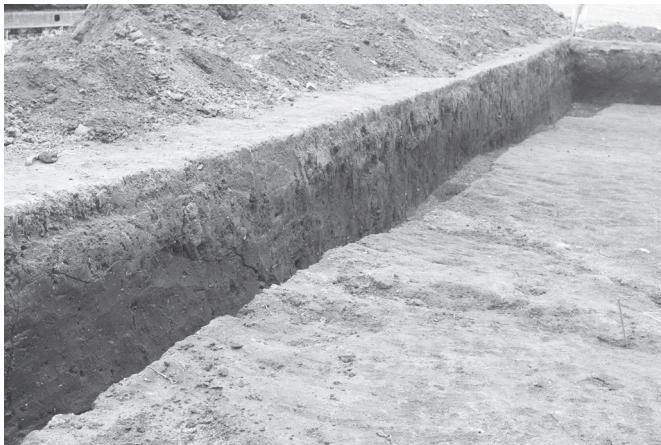
T4 土層断面（西より）
