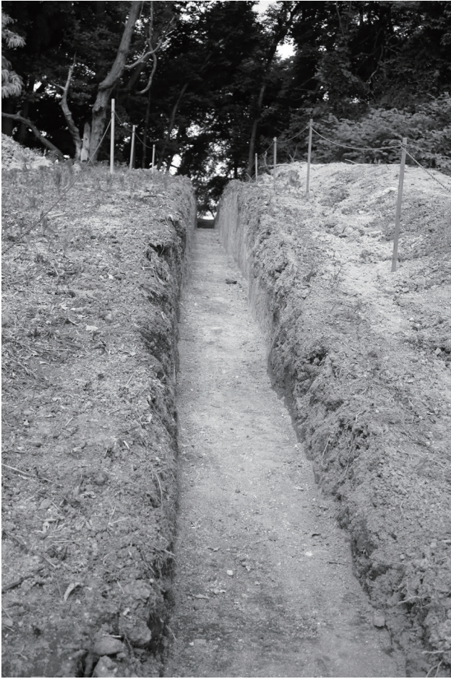
T1 - T3 調査状況 (東より)
