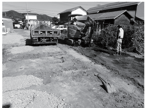
馬場遺跡立会調査状況
