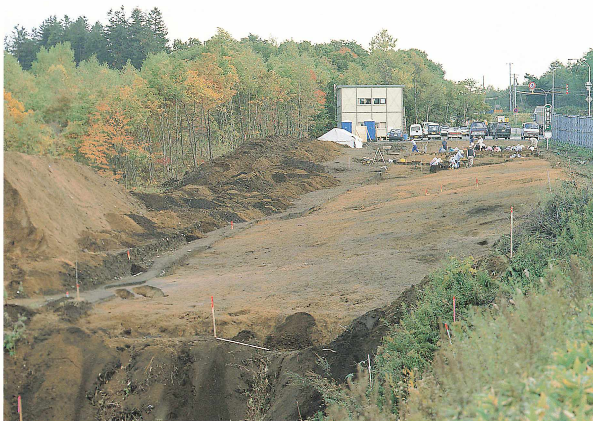
2. 調査区西側完掘状況(NW—SE)
