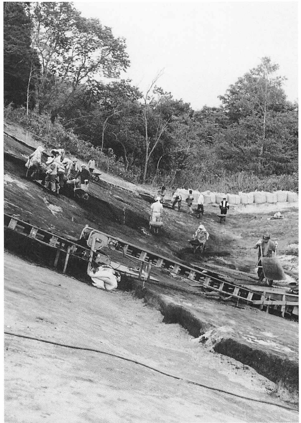
ベルコン使用作業状況
