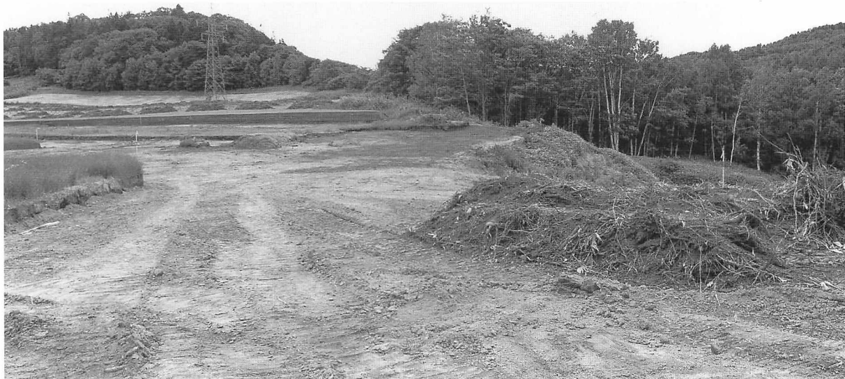
10 埋め戻し作業終了（北東から）
