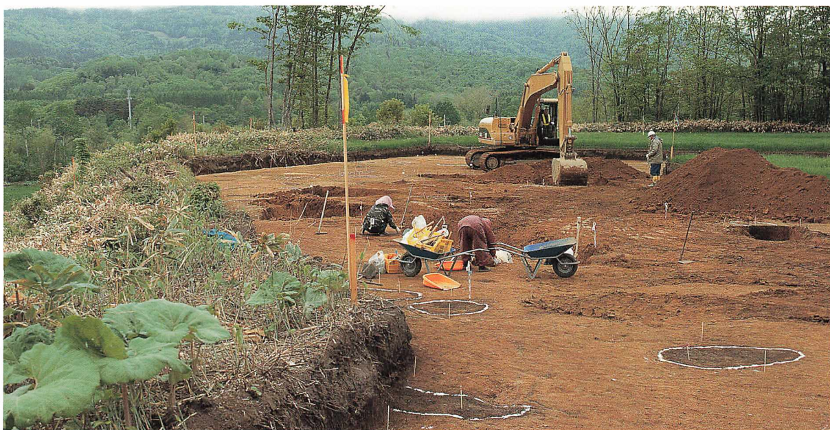
3 TP-87~89調査状況（東から）
