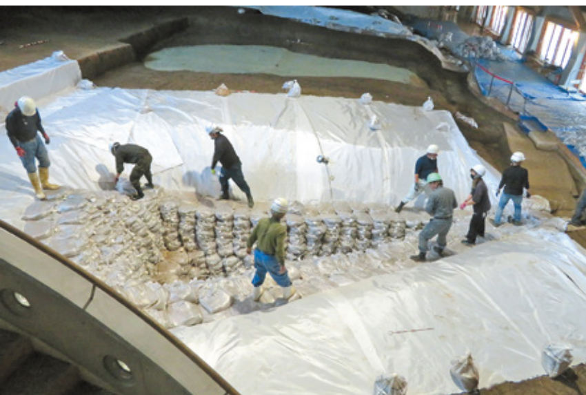
9 酒元ノ上横穴墓群 養生工事状況（北東から）
