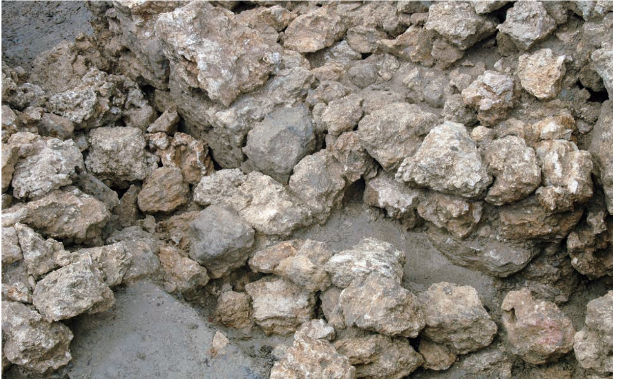
石積2'・3・4 (北西から)
