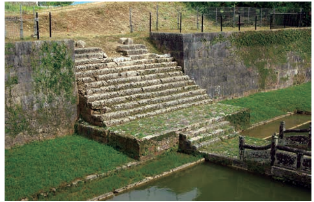
三門階段 取り外し前 (北西から)
