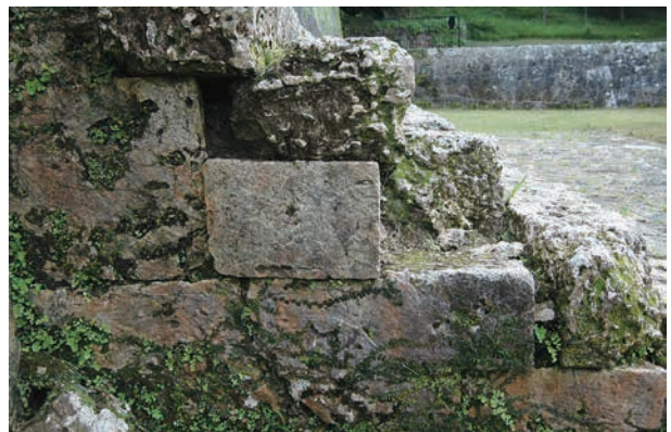
三門階段 (北から)
