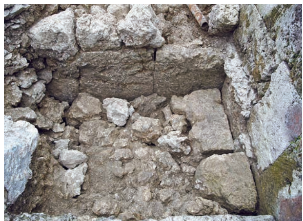
石積2（トレンチ 27内 西から）
