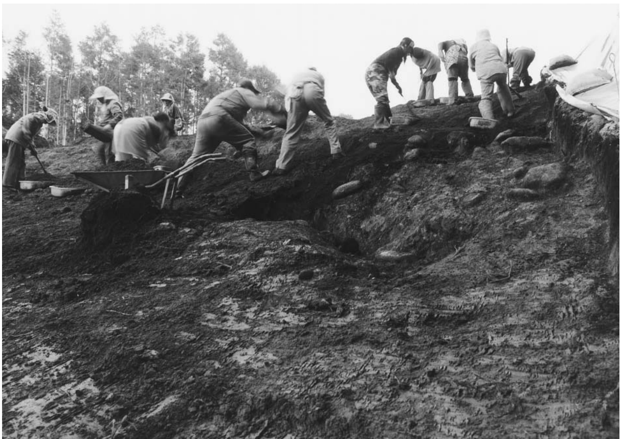
2 斜面作業状況
