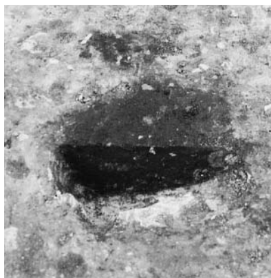
8 NH-22 HP-8 セクション
