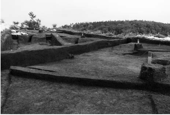
1. III H-4 土層断面D (北西から)
