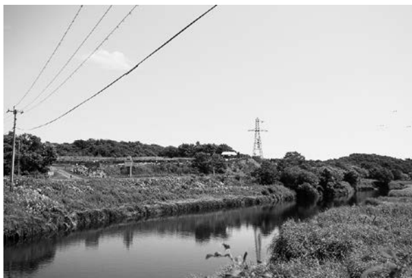
1. B地区遠景（西から）
