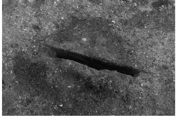
2. III H-15HF-5 断面 (北西から)
