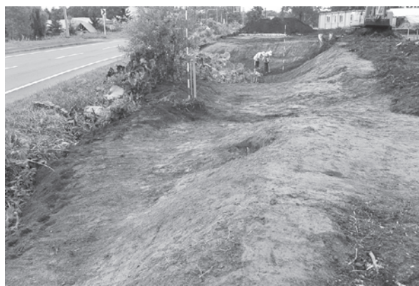
5. 東側斜面部調査状況
