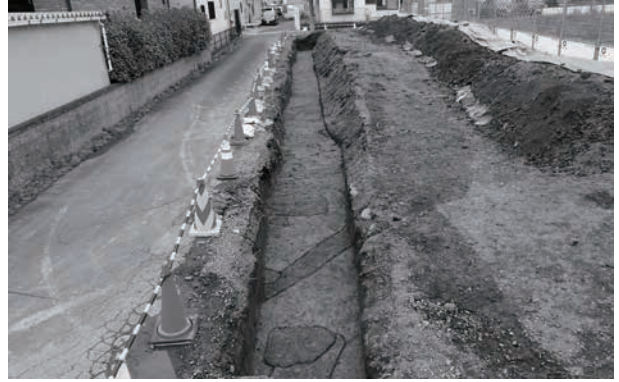
2. S12534 竪穴住居跡検出状況（東から）
