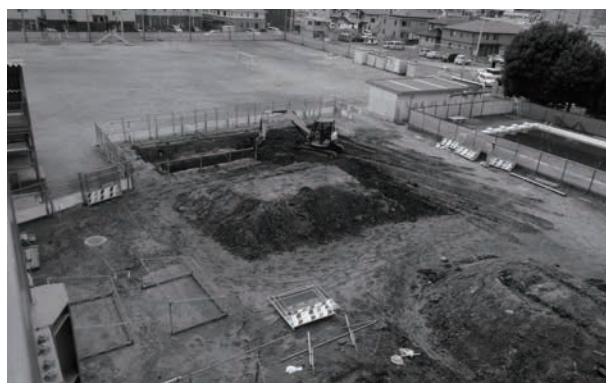
8. I・II区調査区埋戻状況（北東から）
