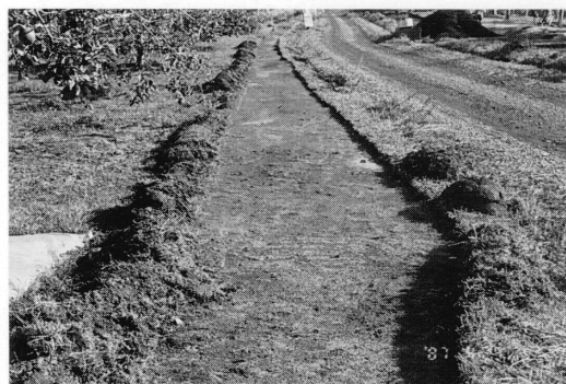
粗掘り終了(表土が薄い状況)
