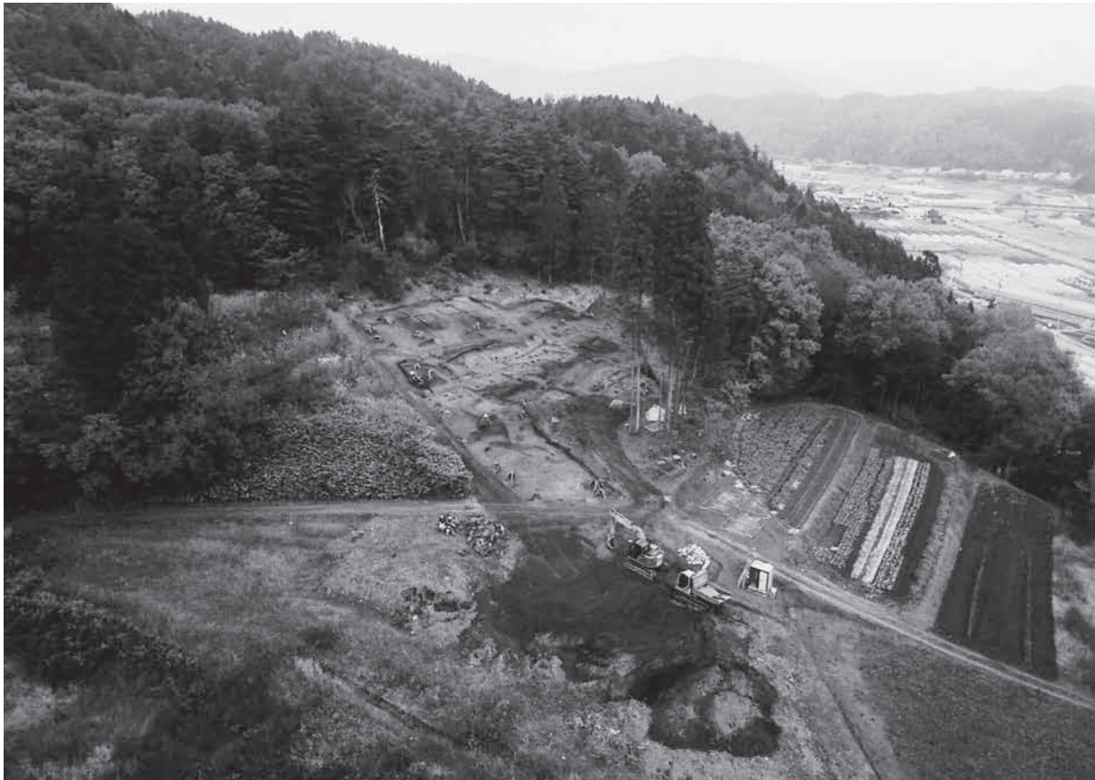
上切寺尾古墳群A地点遠景(南西から)
