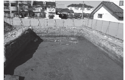
IIId層上面北側 完掘状況 (南から)
