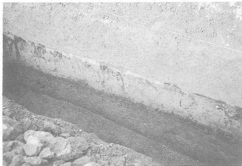
A区第5トレンチ
