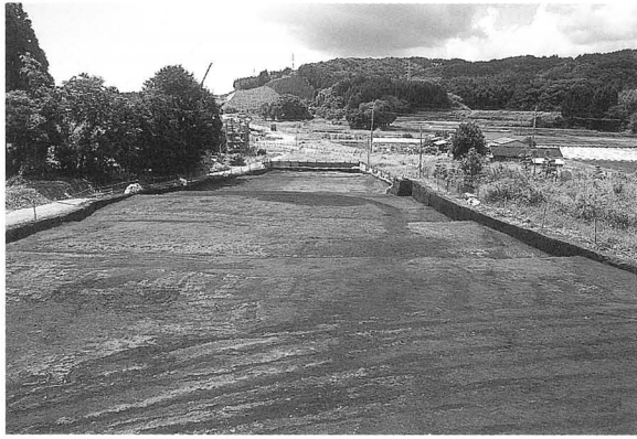
写真2 遺構検出状況
