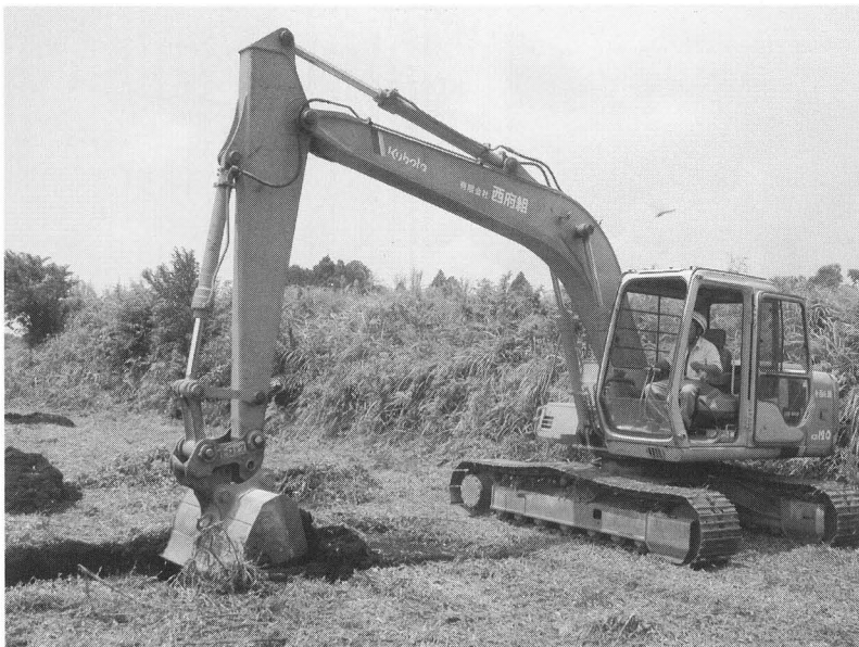
写真2 重機によるトレンチ掘り下げ(東より)
