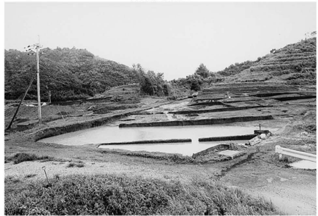
D区水没状況 (南より)
