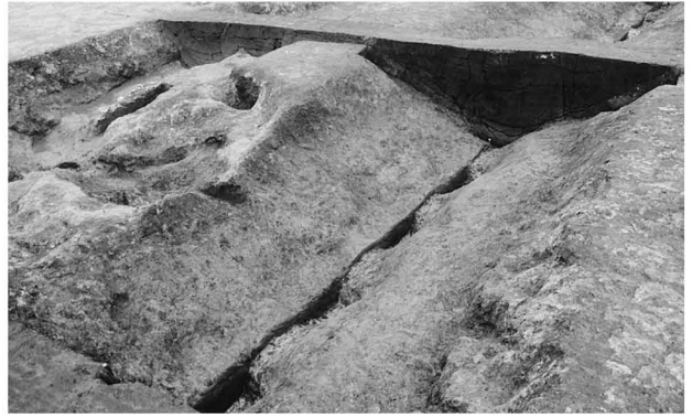
A 1区SG5 (ベルト2～ベルト3) 路面半截状況 (東より)
