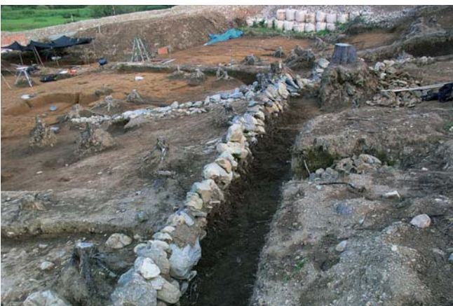
石垣裏込め状況 (1)
