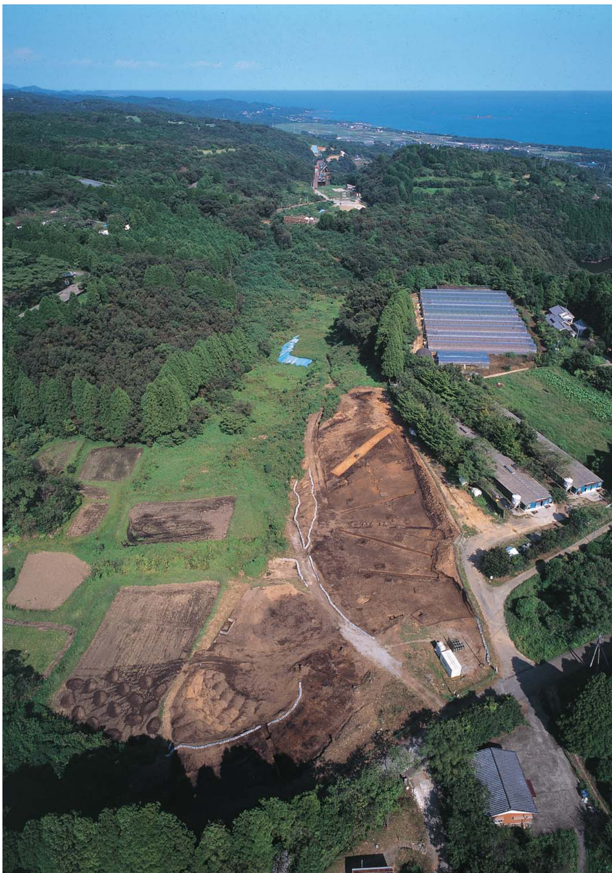
向原中尾遺跡群立地状況（1）（南西から）
