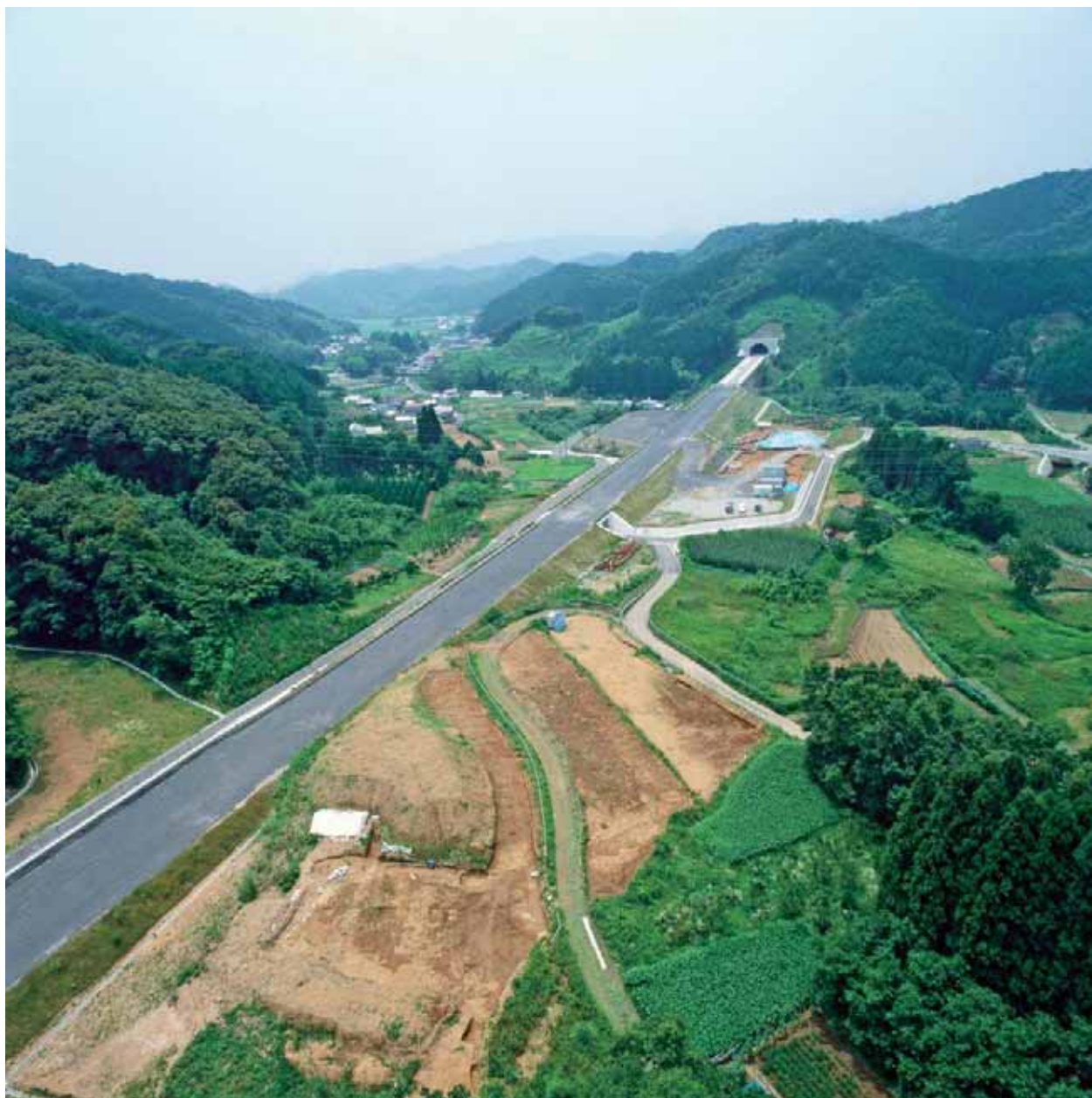
第4次調査区全景（北より）
