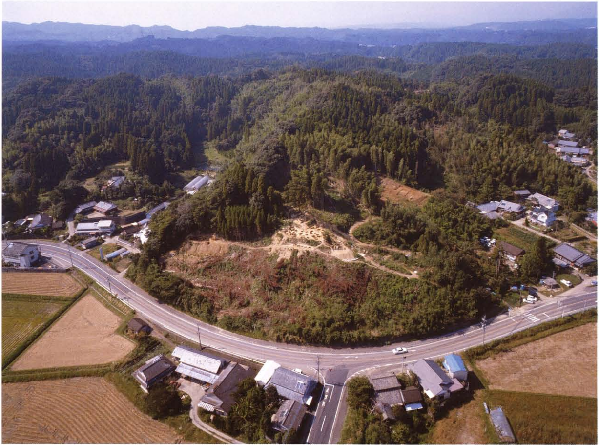
巻頭カラー1 遺跡遠景（南東から）
