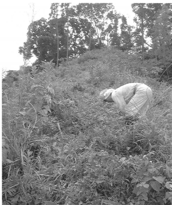
尾根部伐採作業の状況
