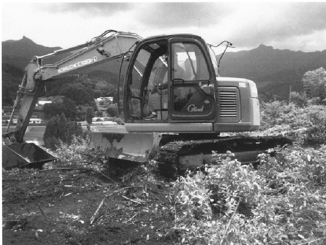
重機による掘削
