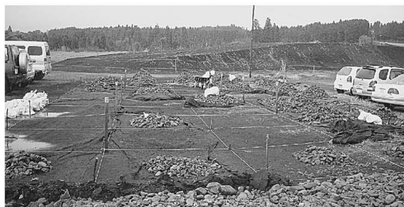
写真5 礫仮置き状況
