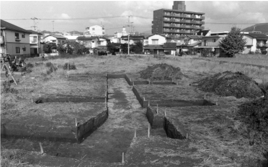
2. 1区掘削状況 (南より)
