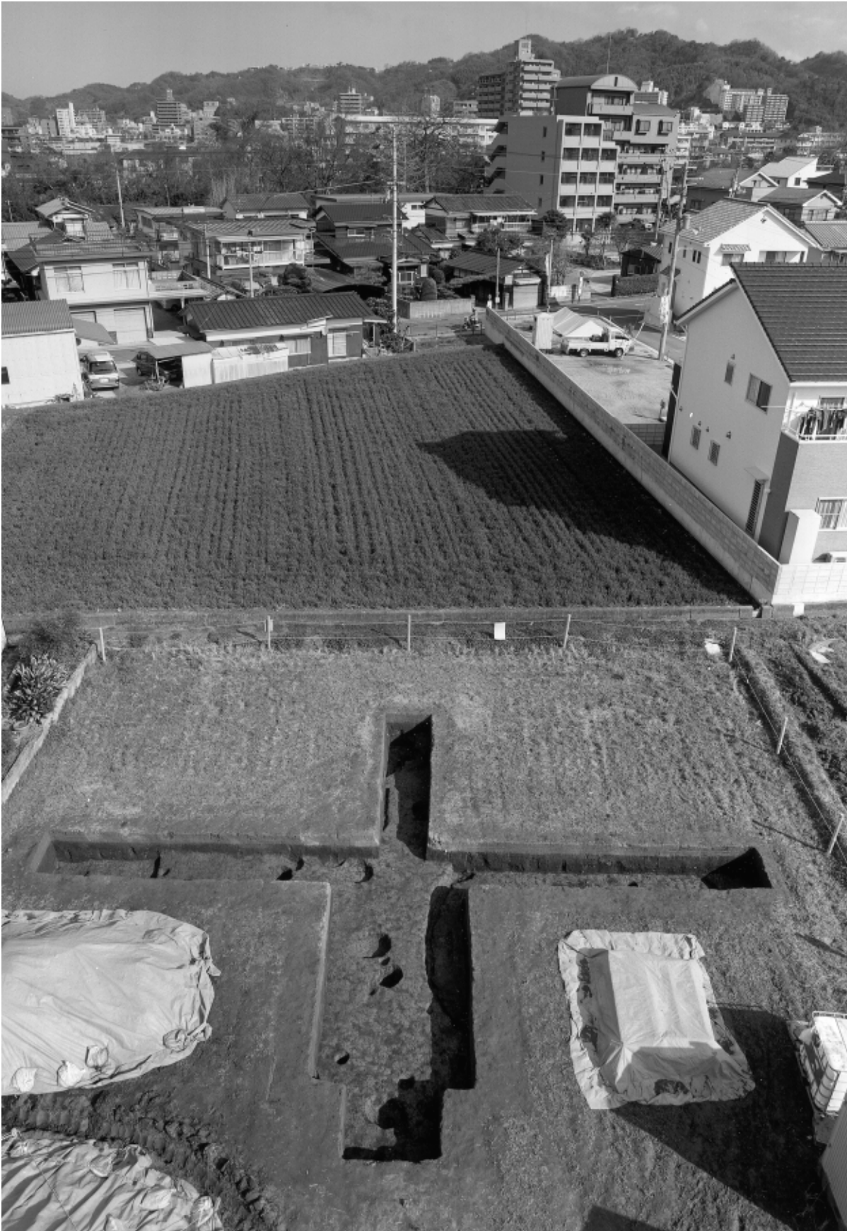
1. 調査地全景 (南より)
