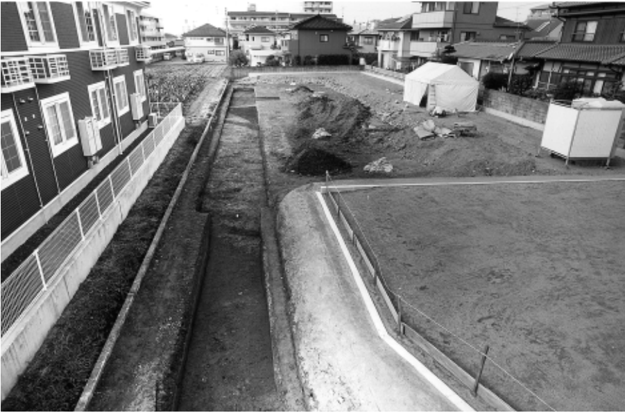
1. 東半部遺構検出状況 (東より)
