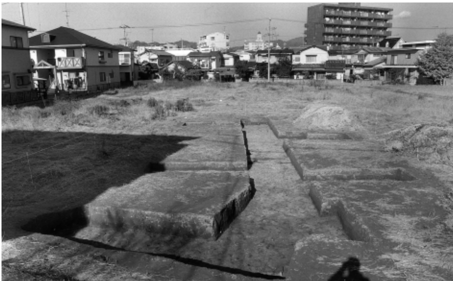
3. 1区完掘状況(南より)
