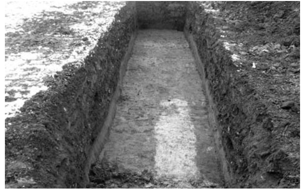
4. 確認調査5トレンチ全景 (北から)
