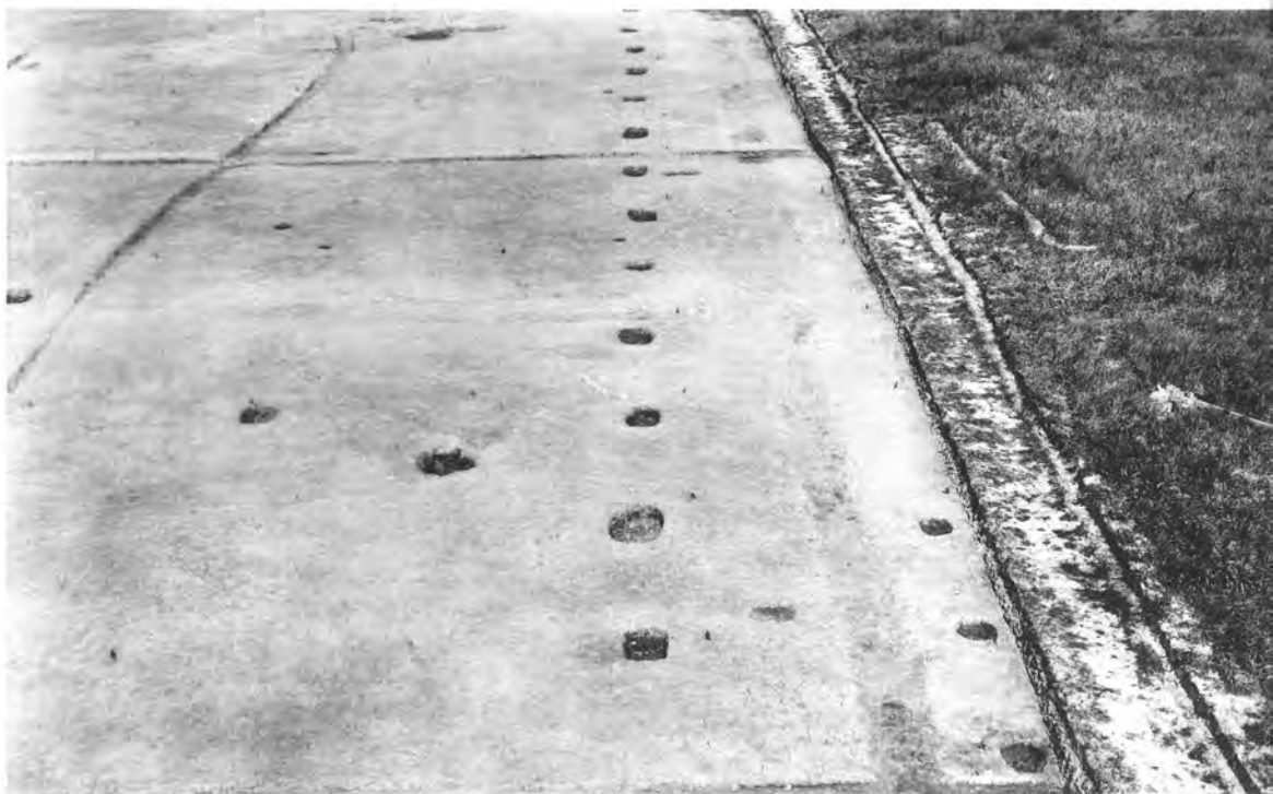
3. 塀 SA3740 西から
