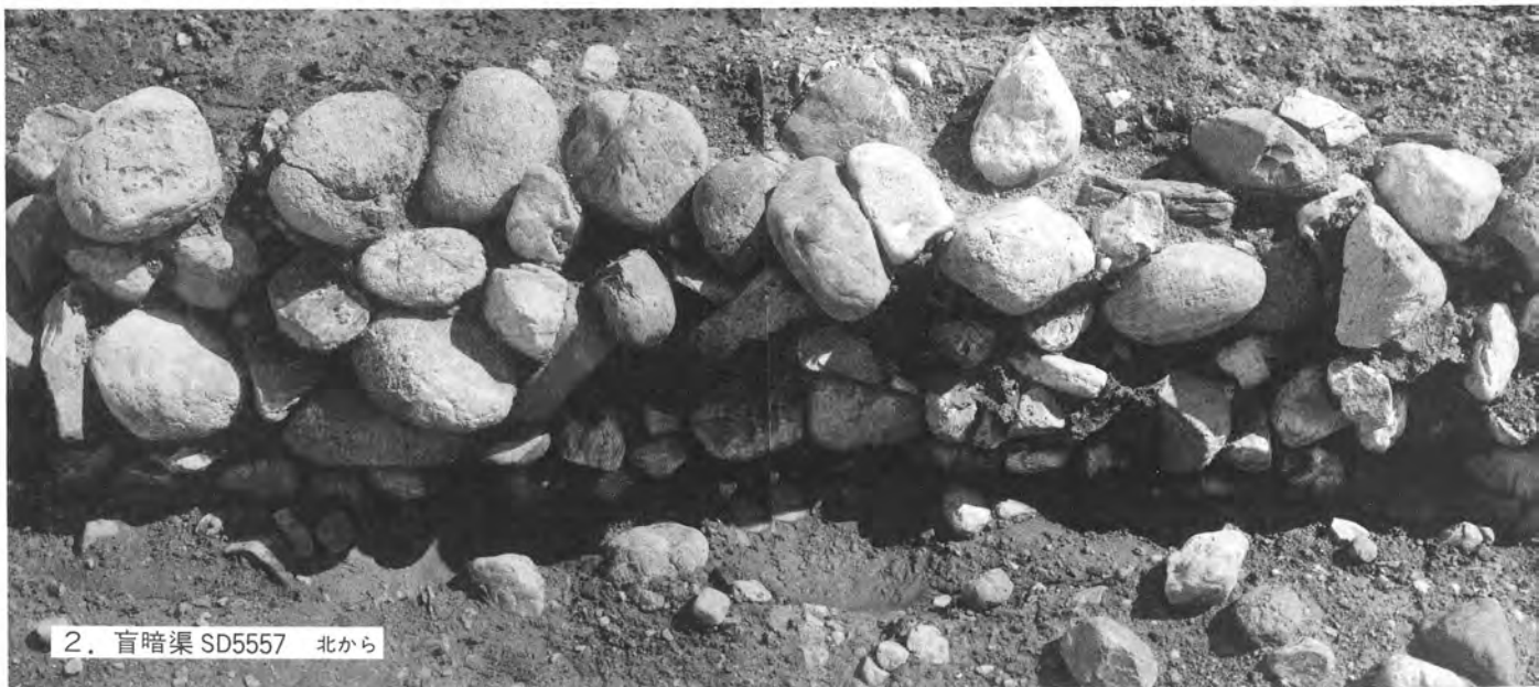
1. 盲暗渠 SD5557, 雨落溝 SD7813A 東から
