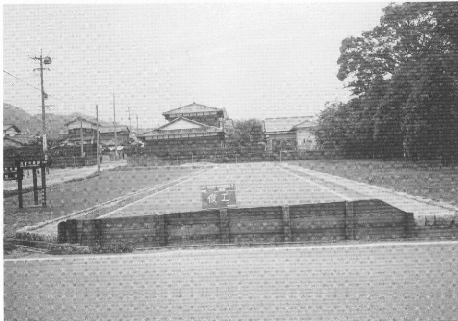
(4) 南面回廊整備後
