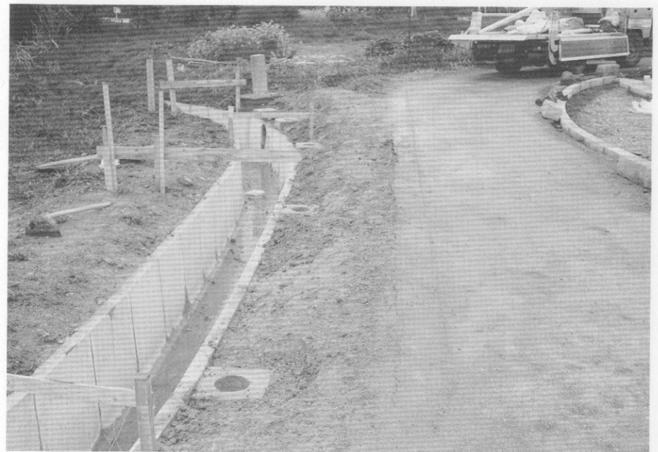
(2) 水路改修U字型側溝付設状況
