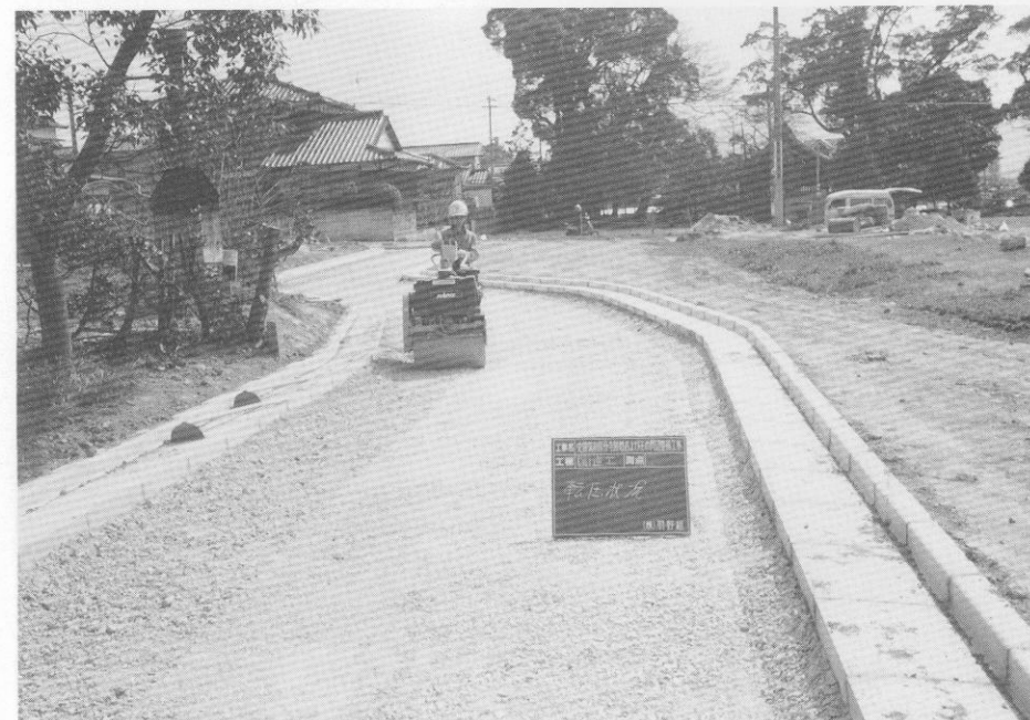
(2) 園路路盤工事転圧状況
