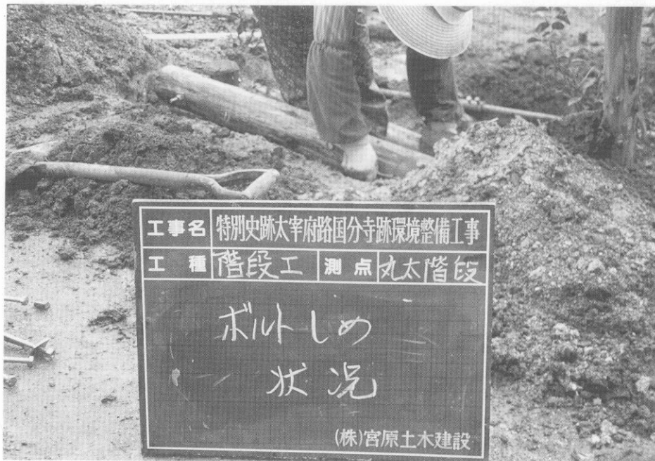
(3) 講堂跡東側丸太階段据付工事
