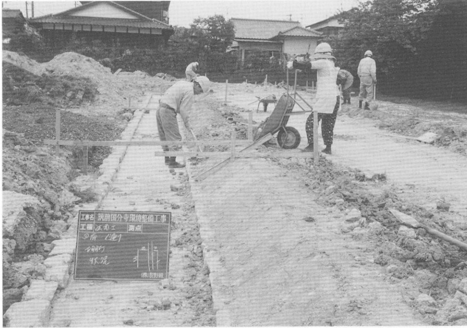
(3) 回廊跡基壇法面工事
