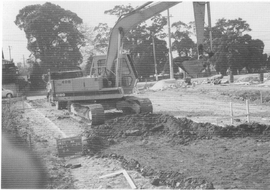
(3) 園路路盤工事
