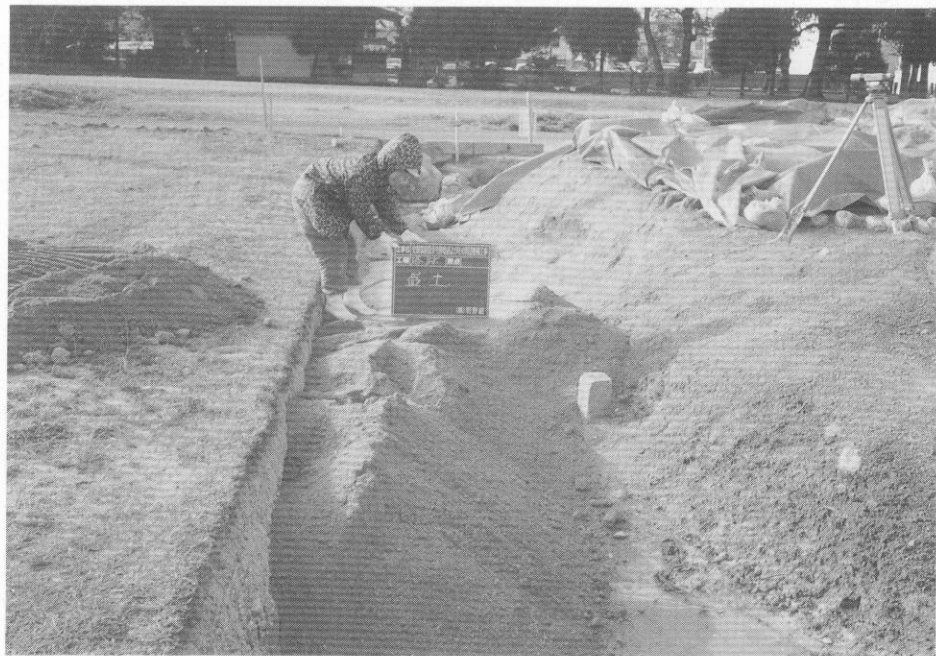
(3) 塔跡盛土工事状況
