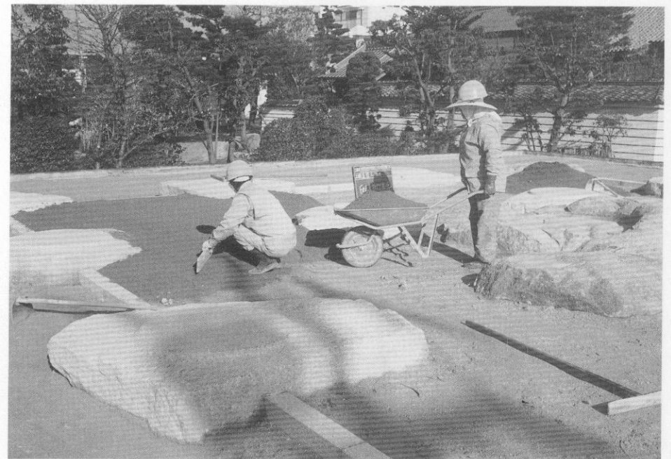
(1) 塔跡基壇表層土壌固化舗装状況
