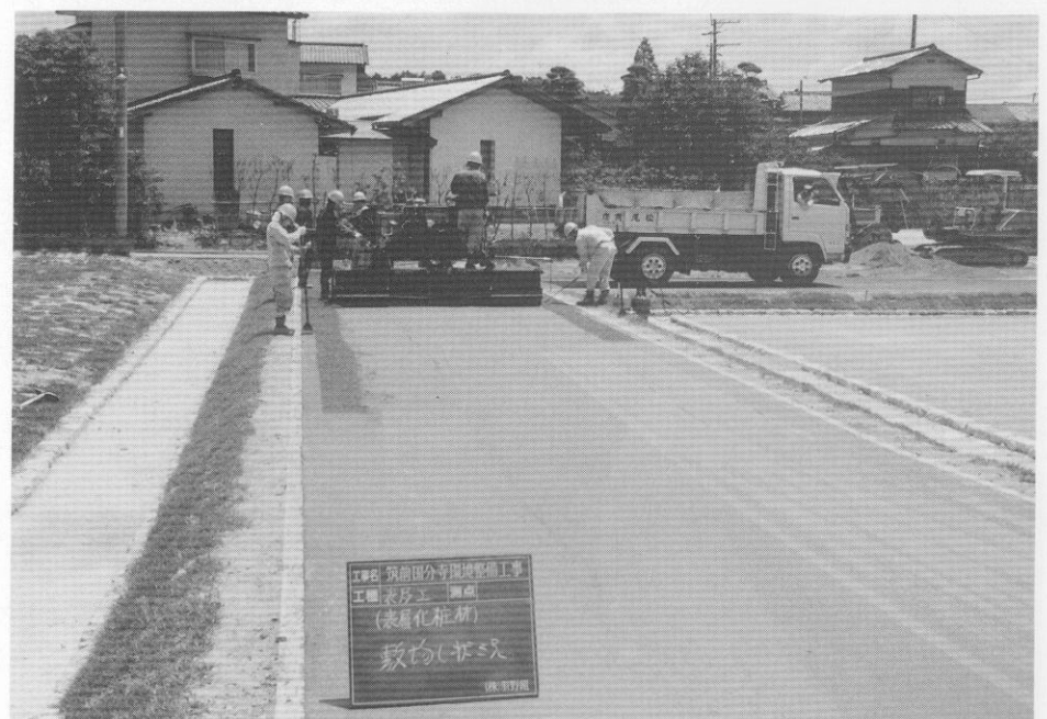
(2) 回廊跡基壇脱色アスファルト舗装工事
