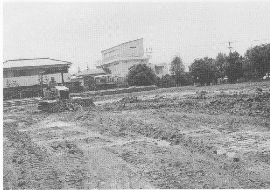
(2) 僧房跡推定地整地工事
