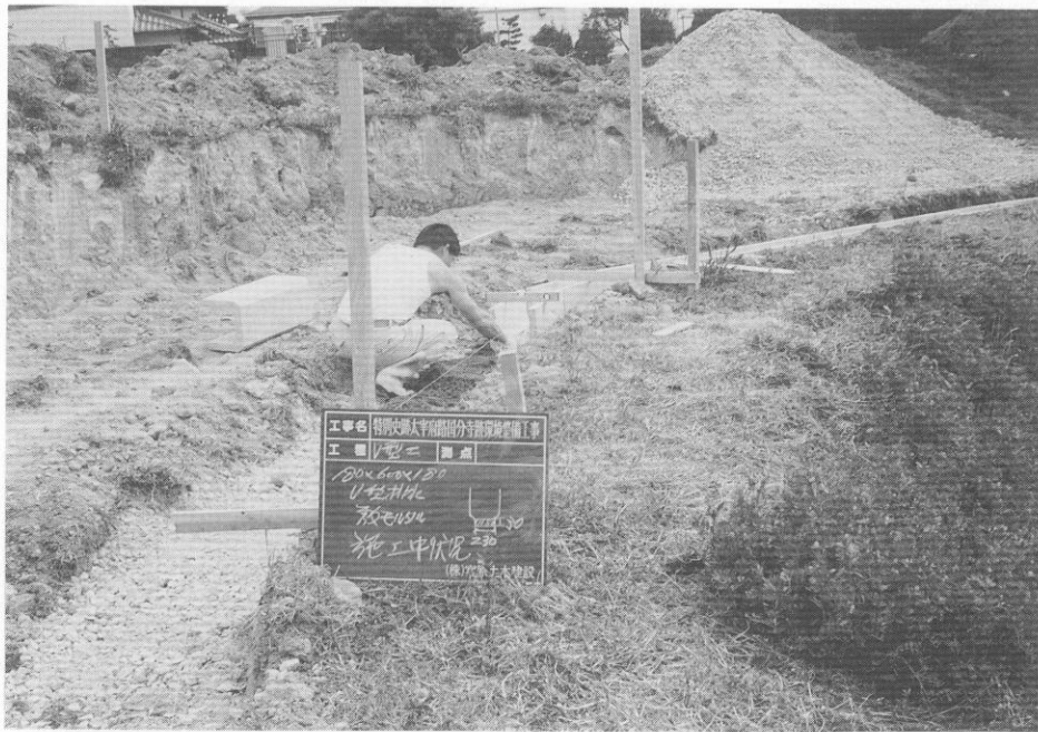
(1) 排水溝付設工事
