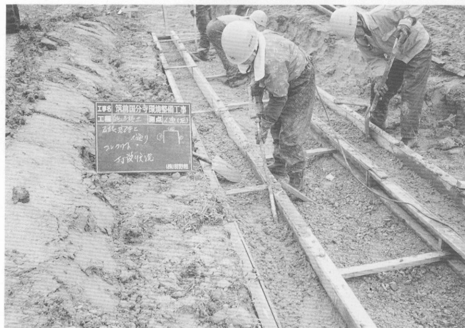
(1) 回廊跡雨落溝石積み基礎コンクリート打設状況
