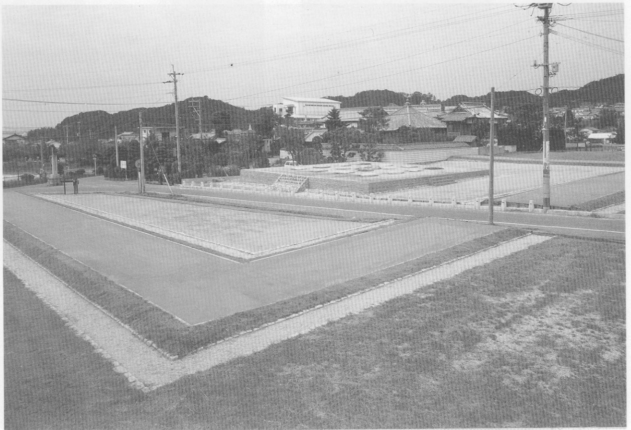
(1) 整備後の状況（東南から）
