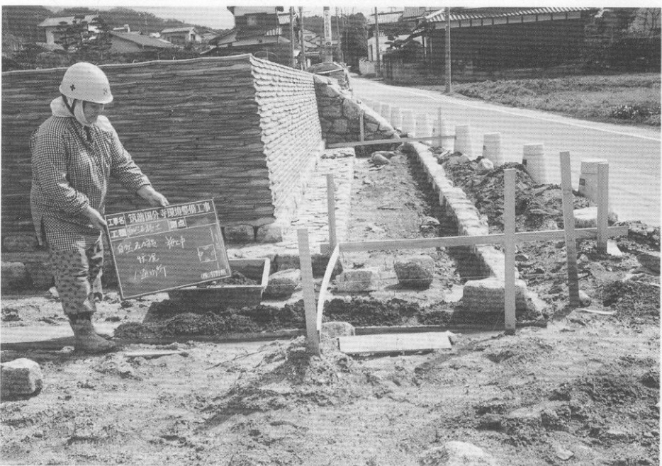
(4) 塔跡雨落溝石積み状況
