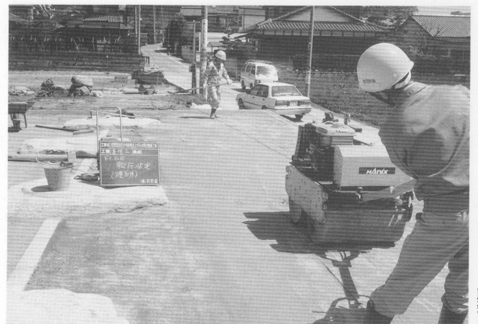
(2) 塔跡基壇表層土壌固化舗装状況
