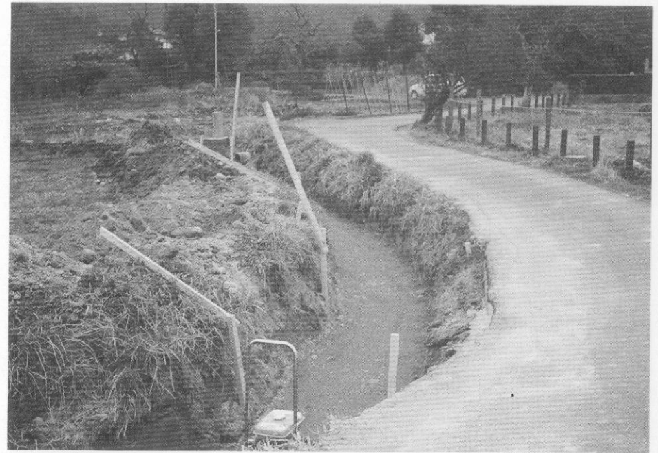
(1) 水路改修路盤工事
