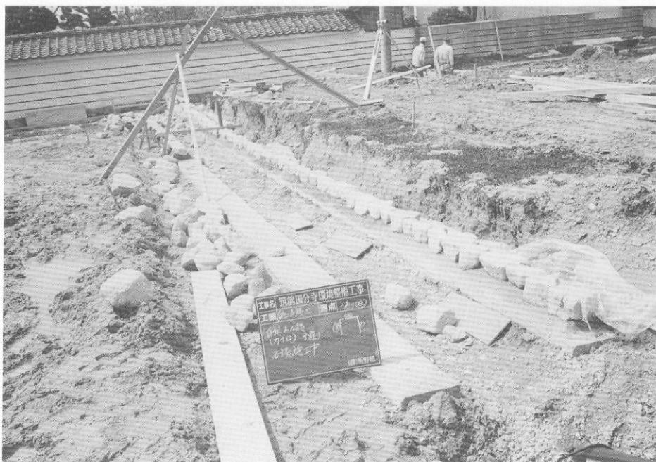
(3) 回廊跡雨落溝石積み状況
