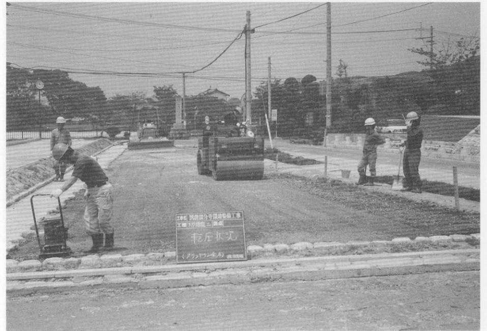
(2) 回廊跡内側路盤工事
