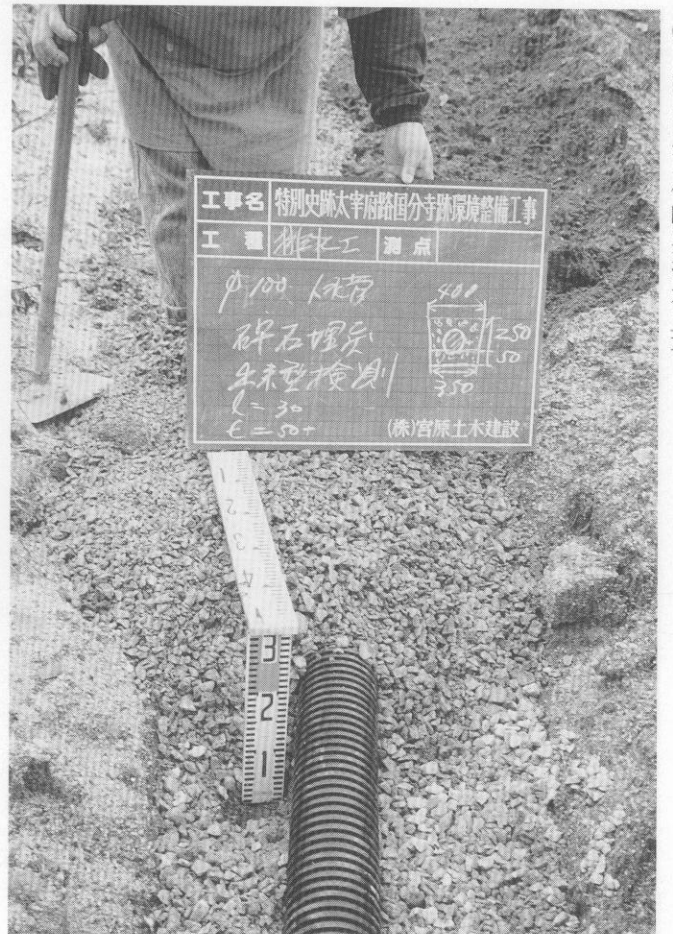
(4) 講堂跡東側暗渠排水工事
