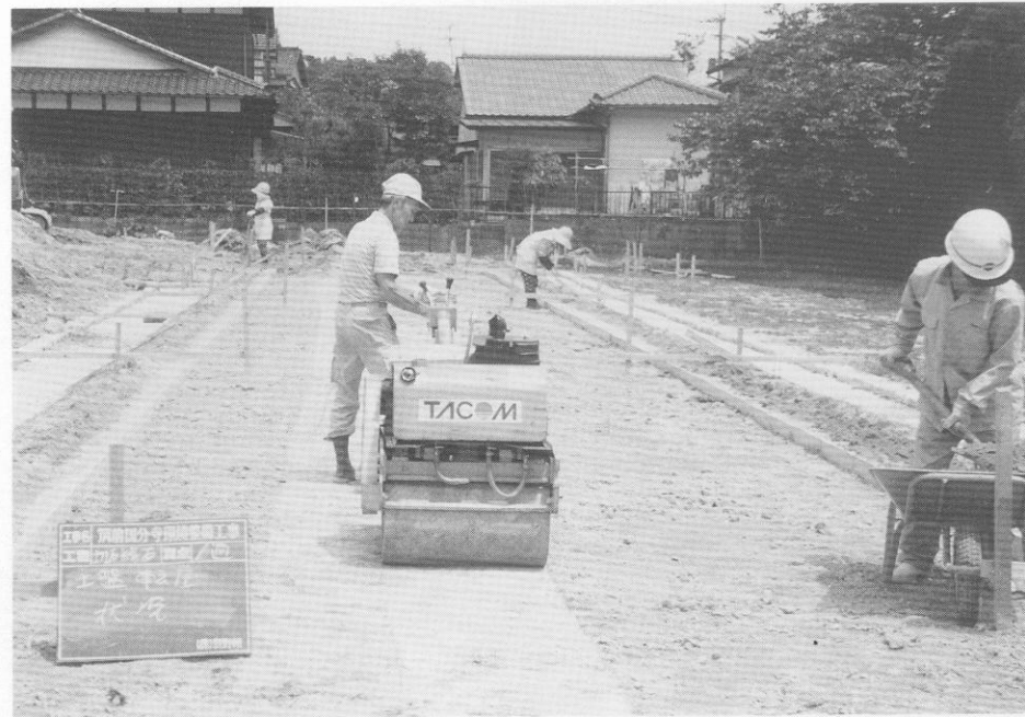
(1) 回廊跡基壇土盤整備状況
