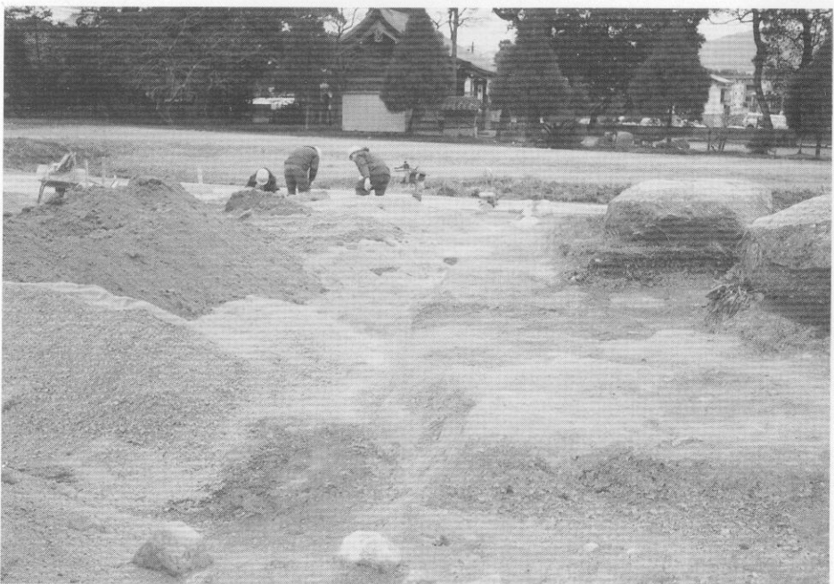
(4) 塔跡盛土工事状況 (洗砂使用)
