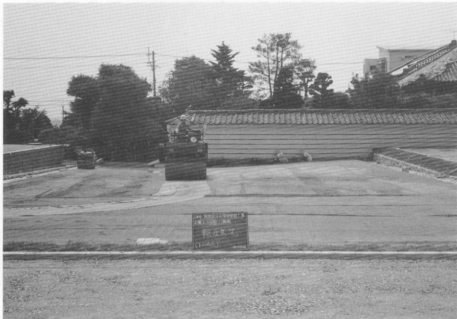
(4) 回廊跡内側土壌固化舗装転圧状況
