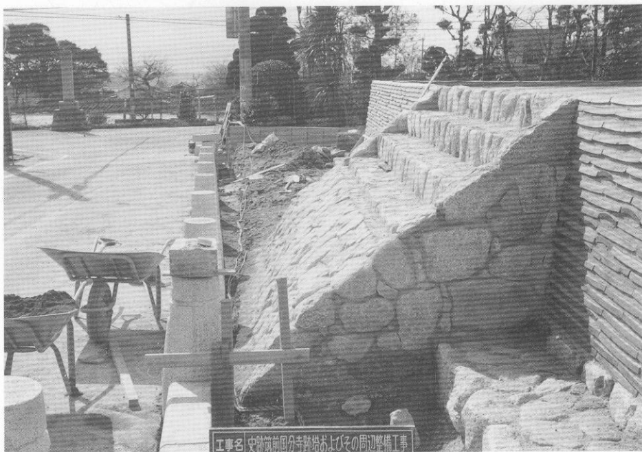
(4) 車止め石柱設置状況
