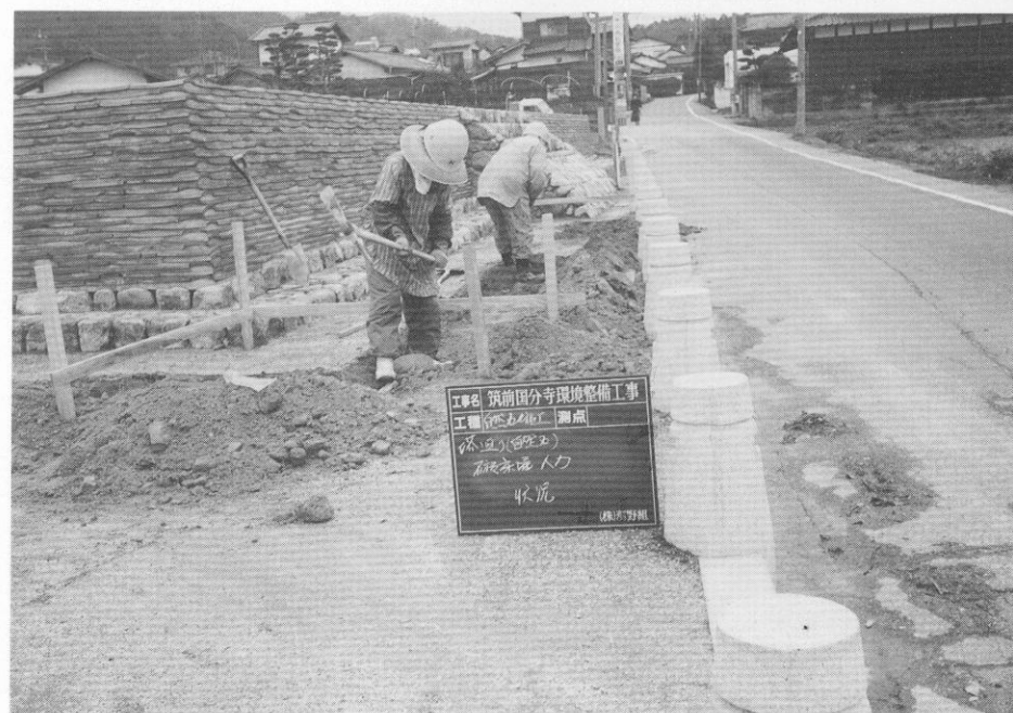
(1) 塔跡雨落溝床掘り状況
