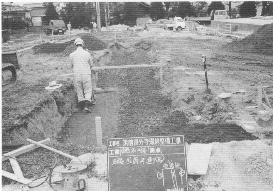
(4) 回廊跡雨落溝路盤工事 (クラッシャーラン敷設)
