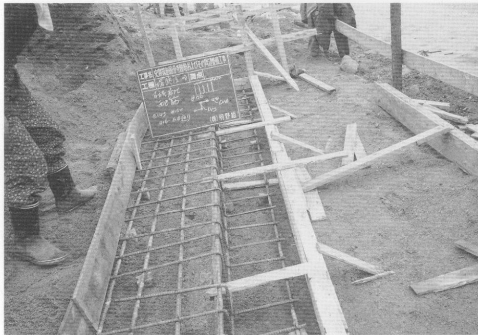
(2) 塔跡基壇基礎配筋状況
