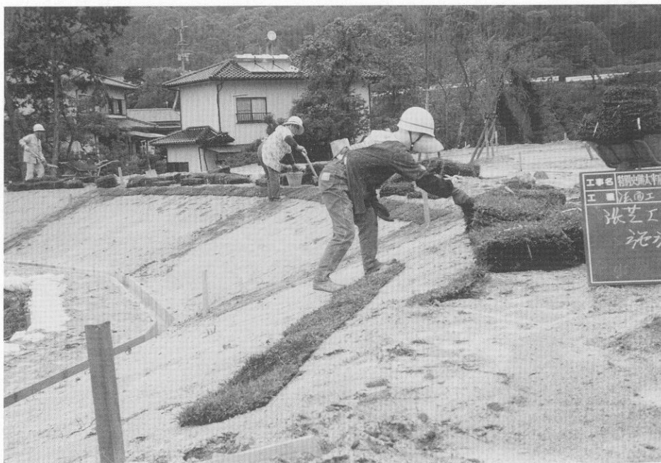
(3) 法面張芝工事
