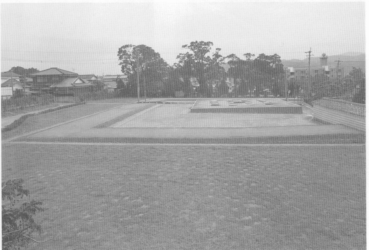
(2) 整備後の状況（北から）
