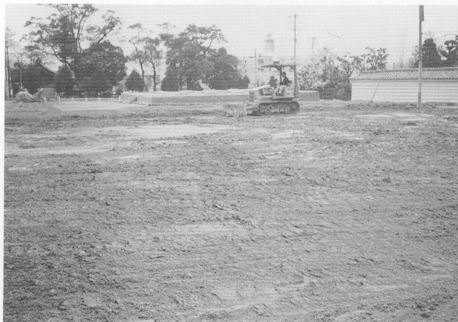
(1) 整地工事状況
