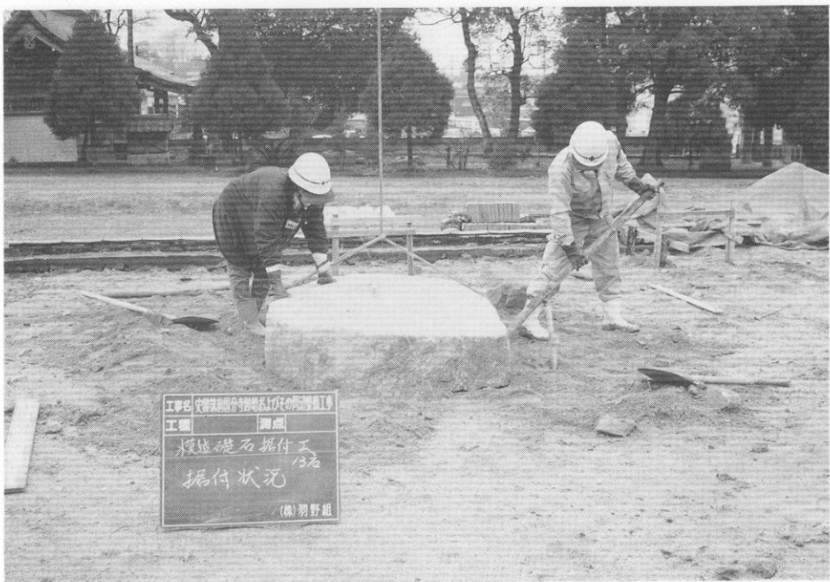
(4) 塔跡模造礎石据付状況
