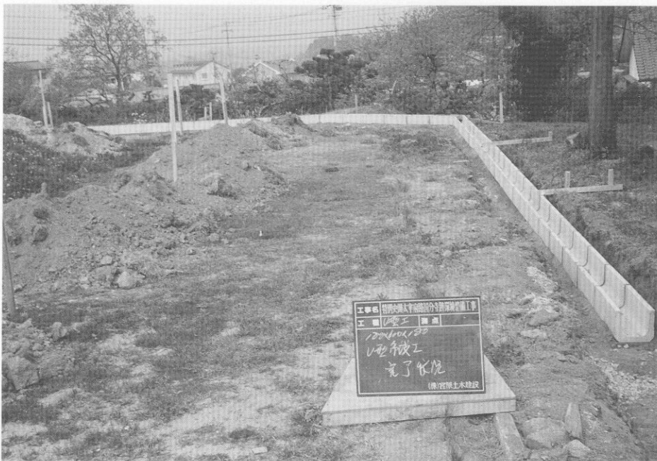
(4) 排水溝付設状況
