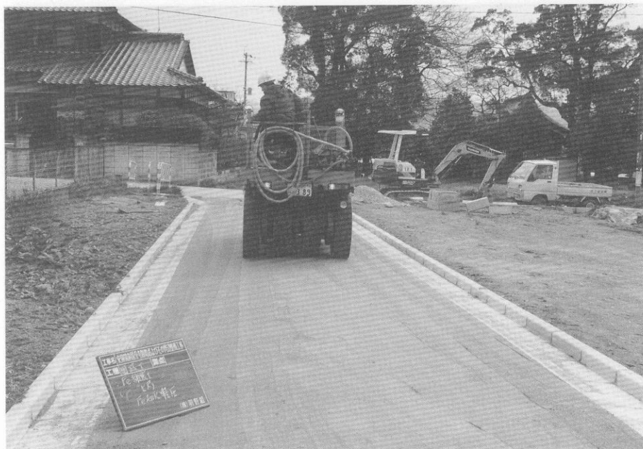
(4) 園路土壌固化舗装上層工事
