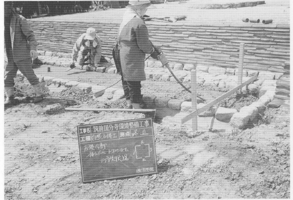
(2) 塔跡雨落溝床コンクリート打設状況
