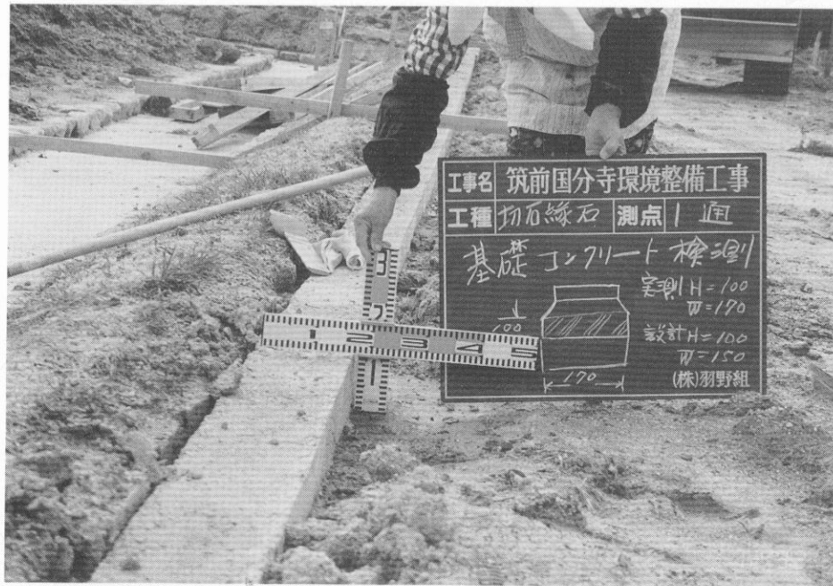
(3) 回廊跡基壇縁石据付け基礎工事
