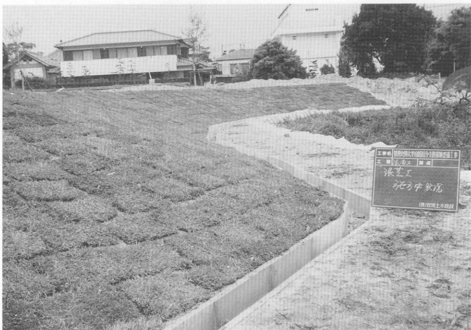
(4) 法面の張芝の状況
