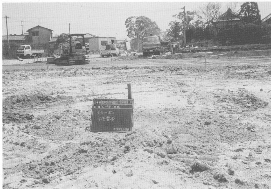
(3) 僧房跡推定地整地工事
