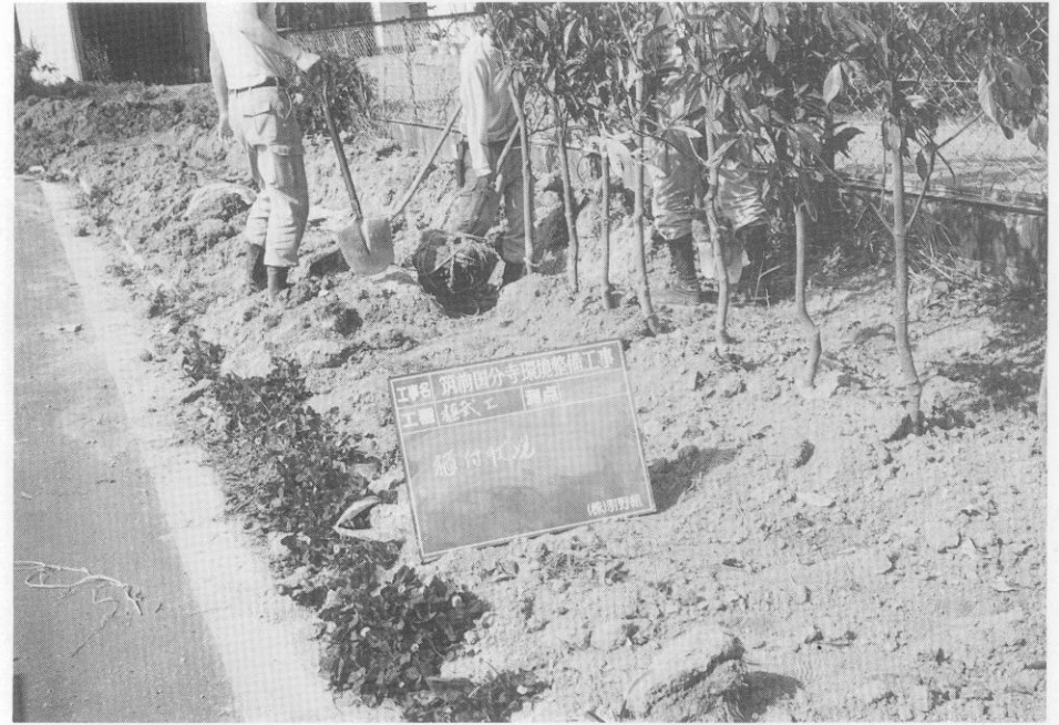
(1) アラガシ植栽状況
