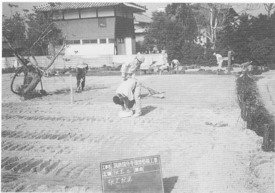
(3) 張芝整地工事
