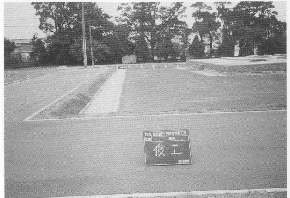
(2) 塔跡東側整備後
