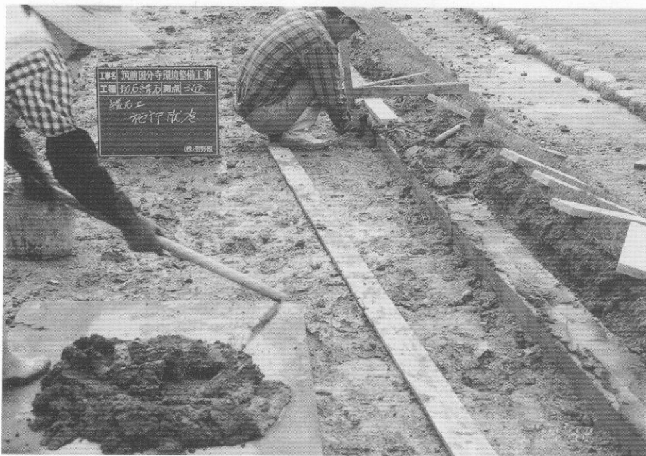
(4) 回廊跡基壇縁石据付状況
