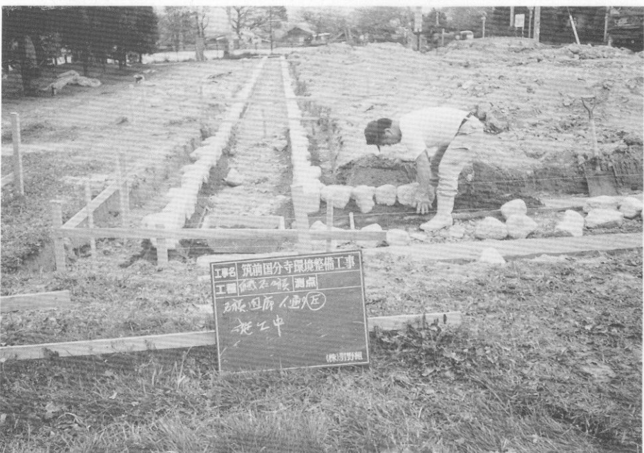
(4) 回廊跡雨落溝石積み状況
