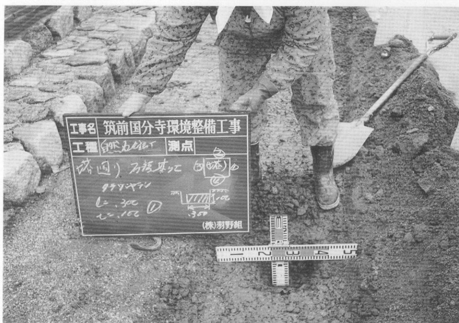
(2) 塔跡雨落溝石積み基礎工事
