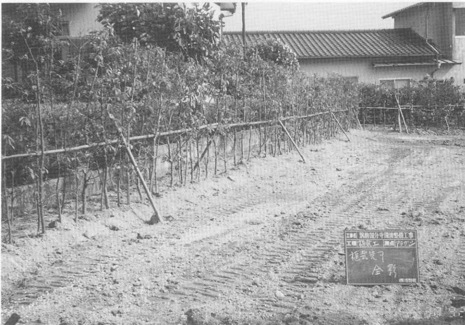
(4) アラガシ植栽状況
