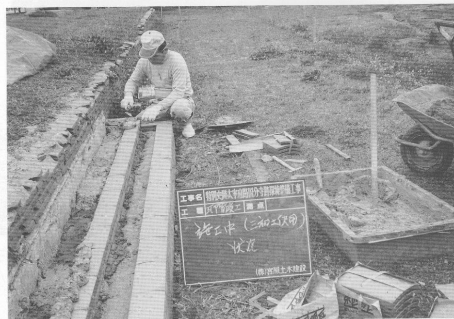
(2) 講堂跡瓦積階段修理工事
