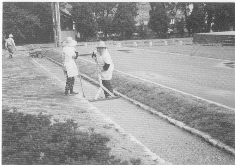
(1) 回廊跡雨落溝砂利敷状況
