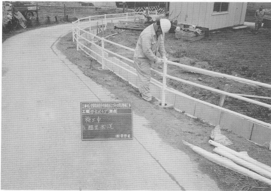
(3) ガードパイプ付設状況
