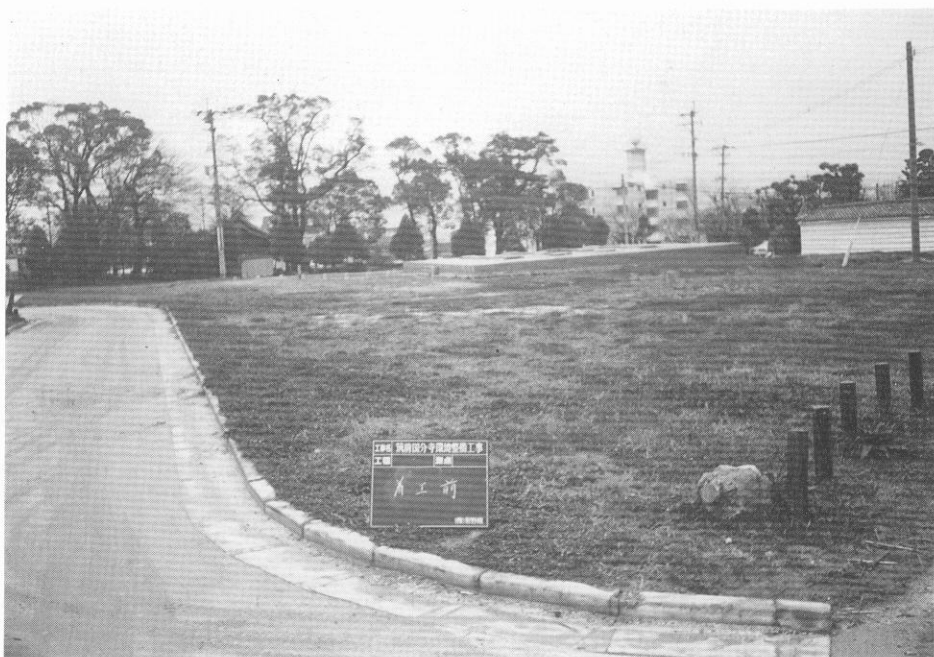
(3) 北面回廊北側整備前
