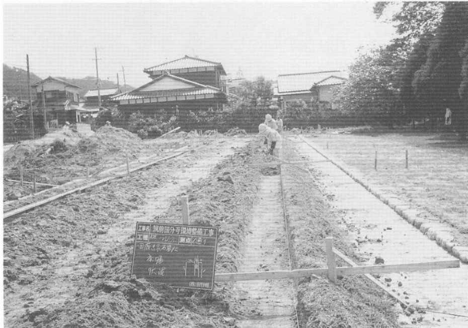
(4) 回廊跡基壇縁石据付床掘り状況
