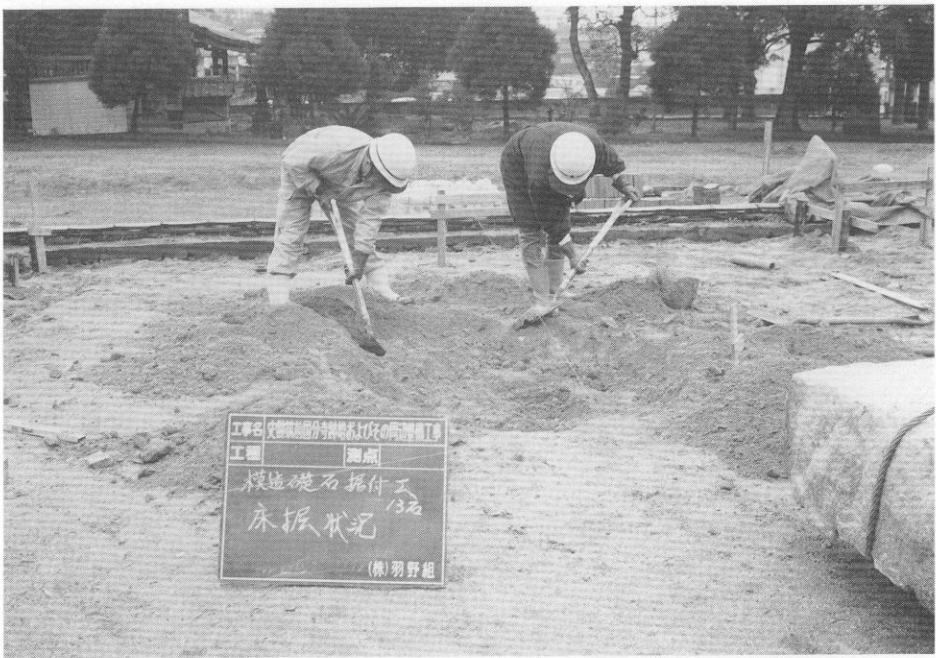
(3) 塔跡模造礎石据付床掘状況
