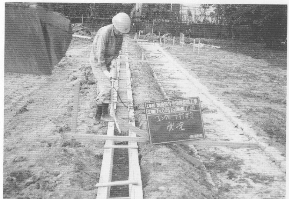
(2) 回廊跡基壇縁石据付基礎コンクリート打設状況
