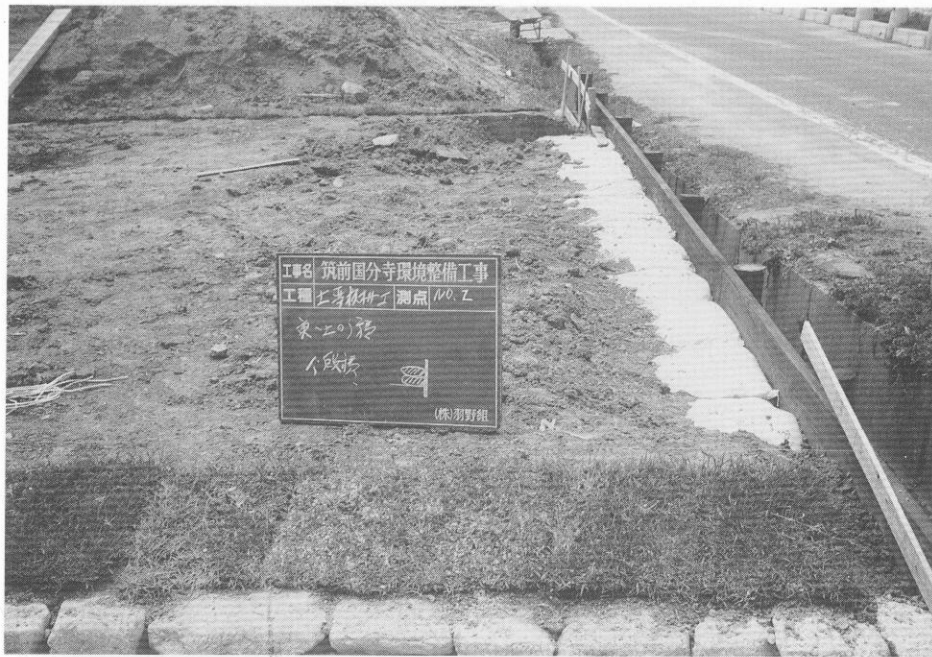
(3) 回廊基壇土留板柵工事
