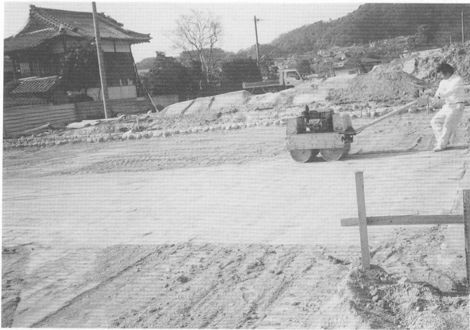
(3) 回廊跡内側整地転圧状況
