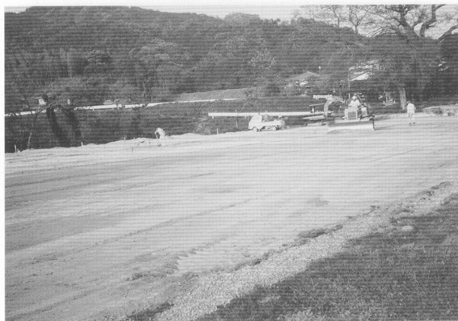
(4) 僧房跡推定地整地工事
