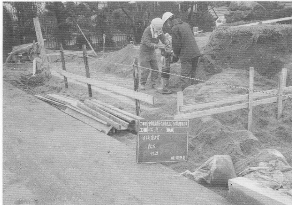
(1) 塔跡盛土転圧状況
