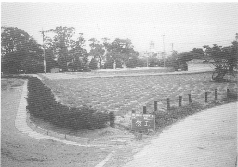
(4) 北面回廊北側整備後
