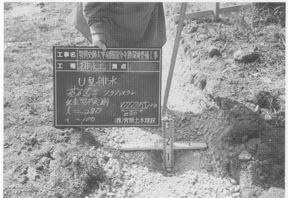
(2) 排水溝付設路盤工事
