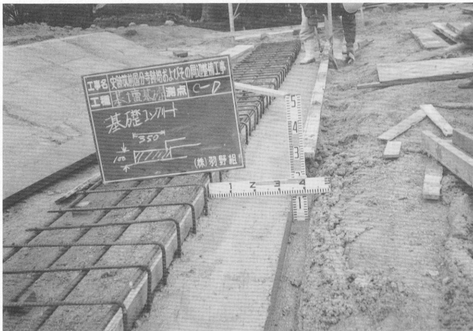
(3) 塔跡基壇基礎コンクリート打設
