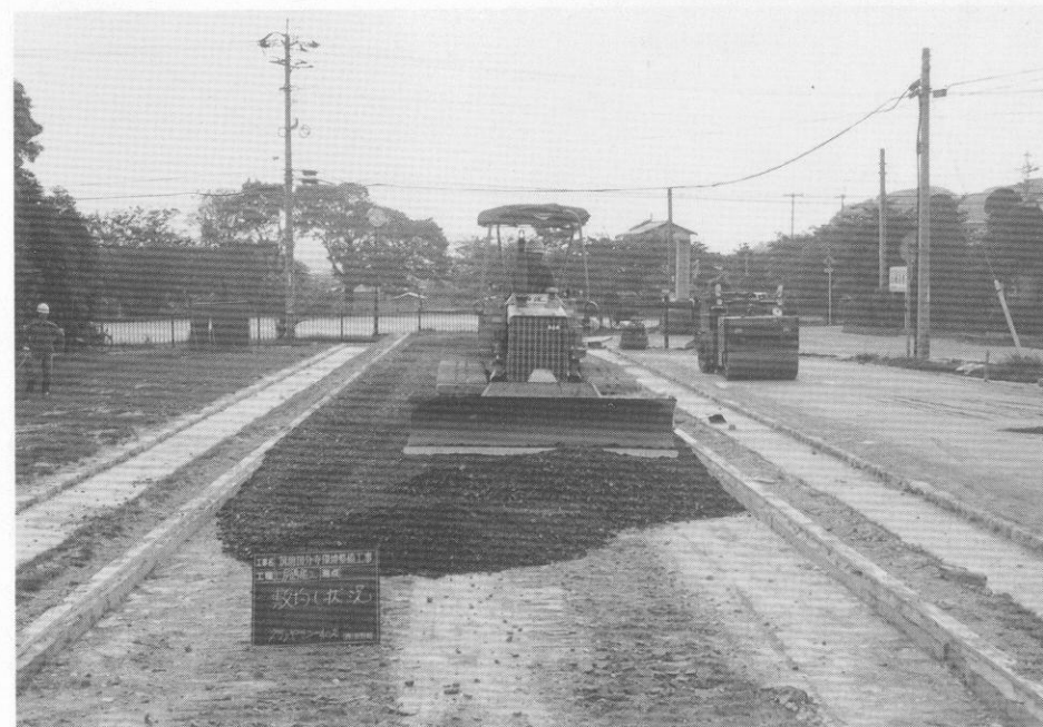
(2) 回廊跡基壇路盤工事
