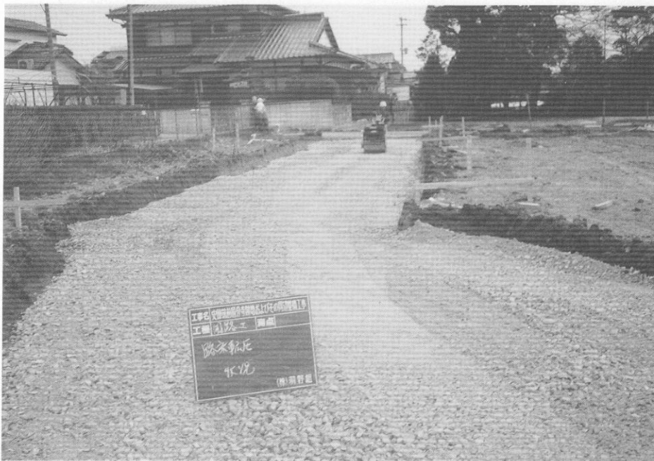
(4) 園路路床(クラッシャーラン)転圧状況
