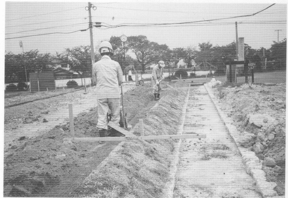
(1) 回廊跡基壇縁石据付路盤工事
