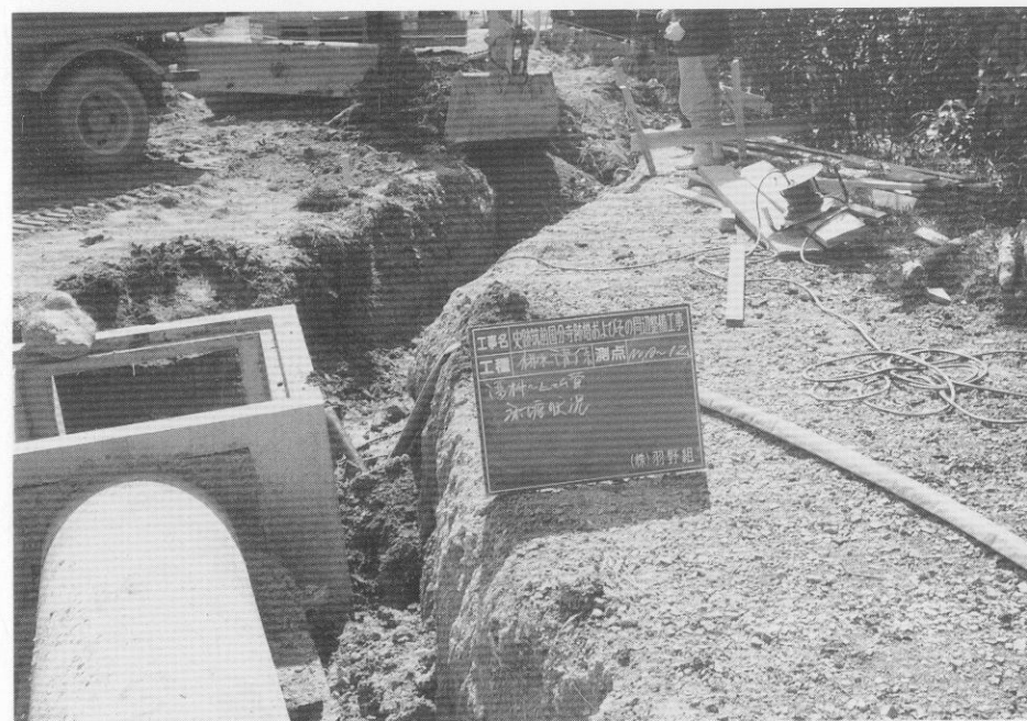
(2) 水路改修暗渠排水工事
