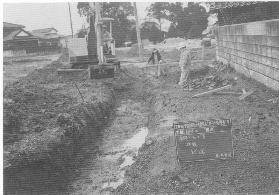
(1) 水路改修暗渠排水工事
