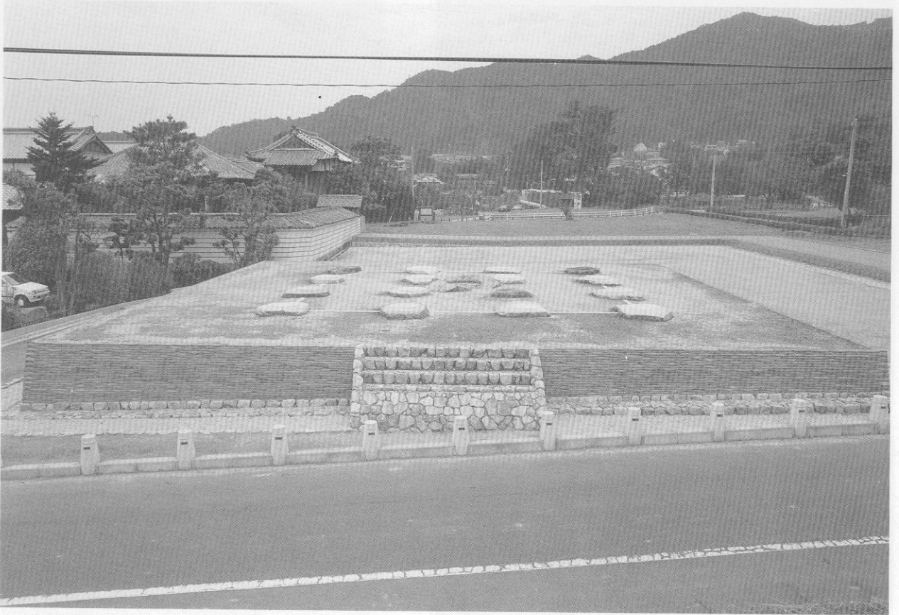
(1) 整備後の塔跡（南から）
