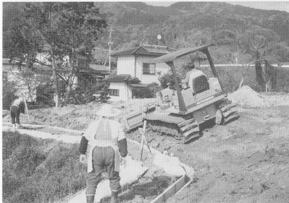
(2) 法面整地工事
