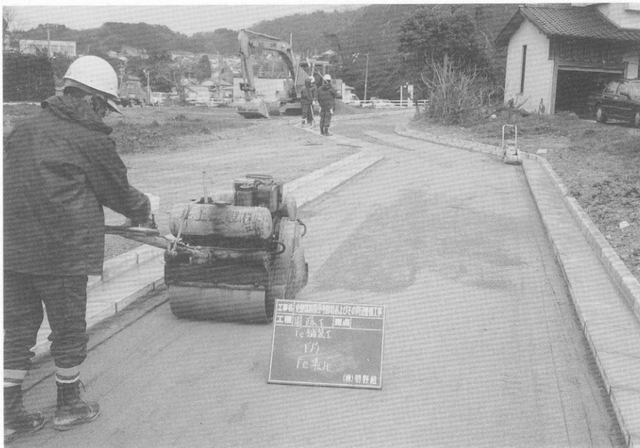
(3) 園路土壌固化舗装下層工事
