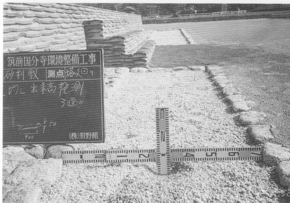
(2) 塔跡雨落溝砂利敷状況
