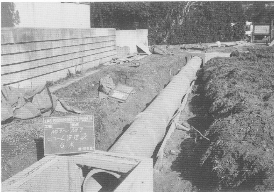
(3) 暗渠排水ヒューム管埋設状況
