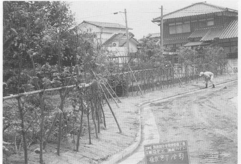
(2) アラガシ植栽状況
