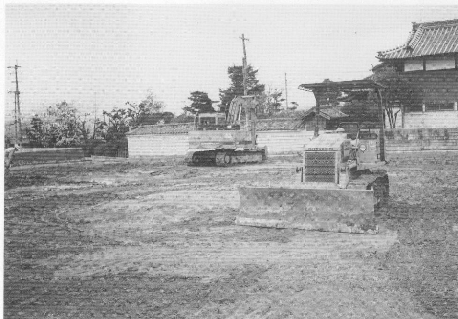
(2) 整地工事状況
