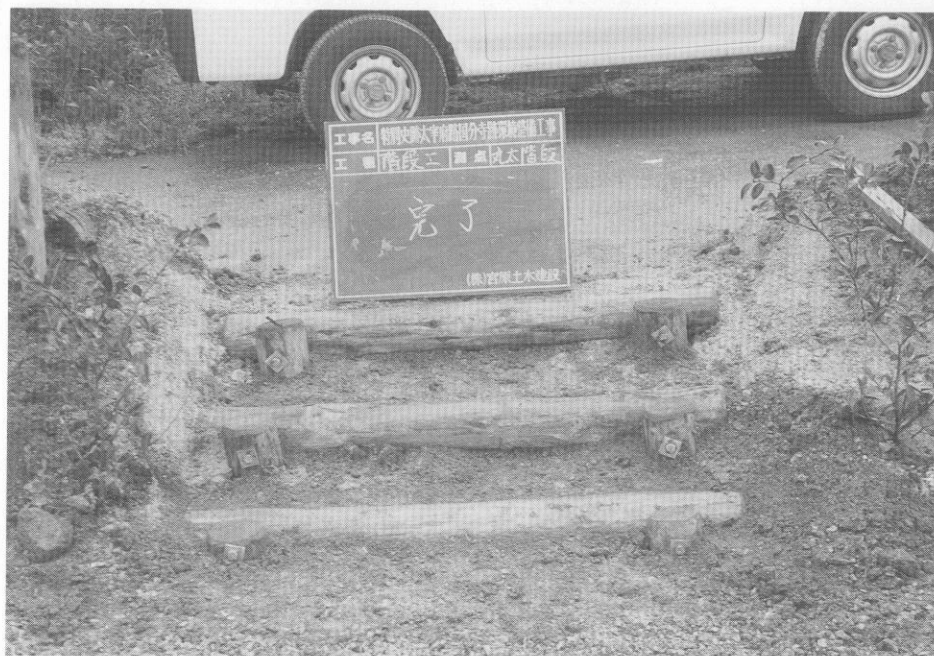
(4) 講堂跡東側丸太階段据付状況
