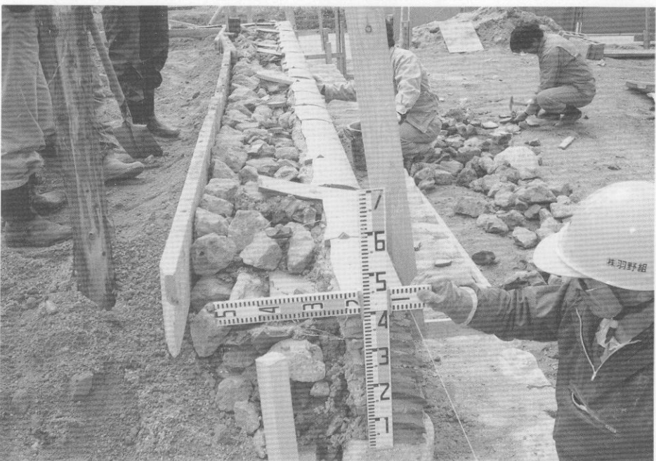
(4) 塔跡基壇瓦積み状況
