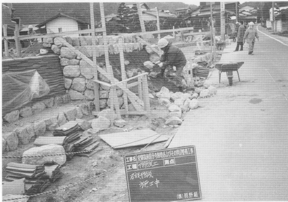
(2) 塔跡基壇南側石組階段工事
