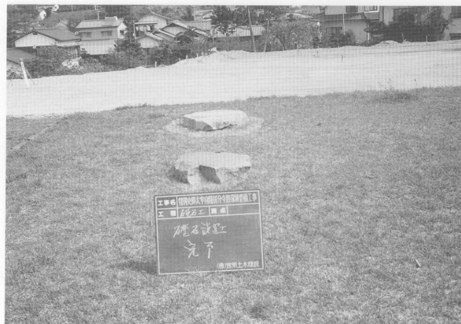
(2) 講堂跡礎石据付け状況
