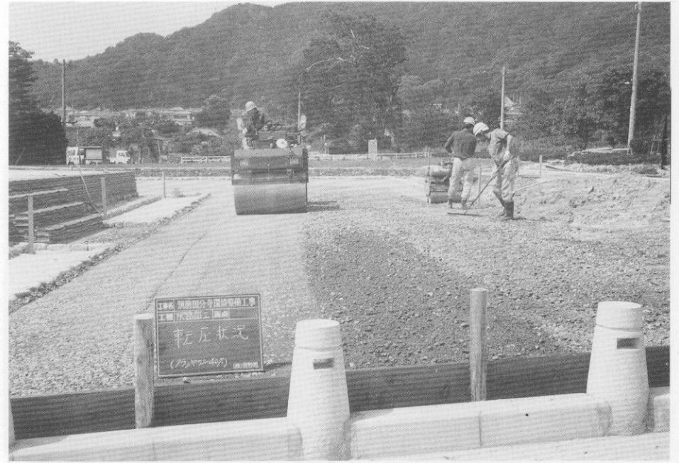
(1) 回廊跡内側路盤工事
