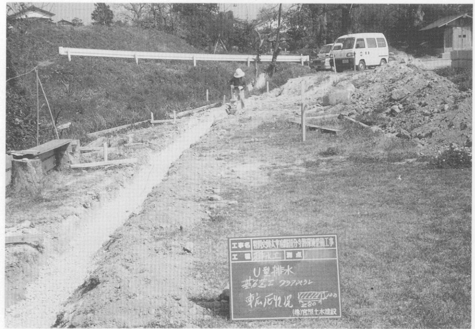
(1) 排水溝付設路盤工事
