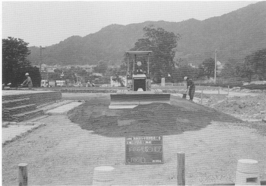
(3) 回廊跡内側土壌固化舗装工事
