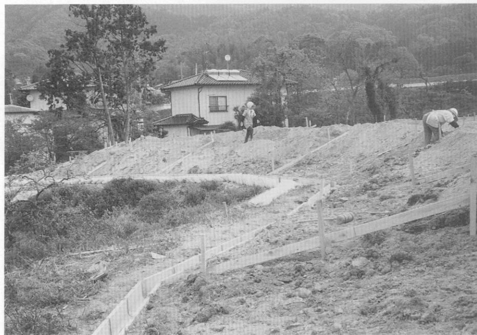
(1) 法面整地工事
