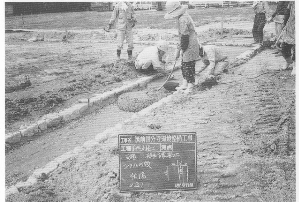
(2) 回廊跡雨落溝床コンクリート打設状況
