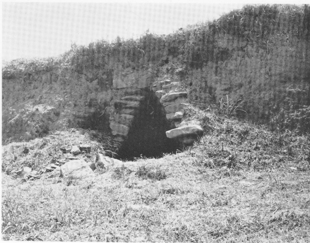
1 原口1号墳奥壁（調査前）
