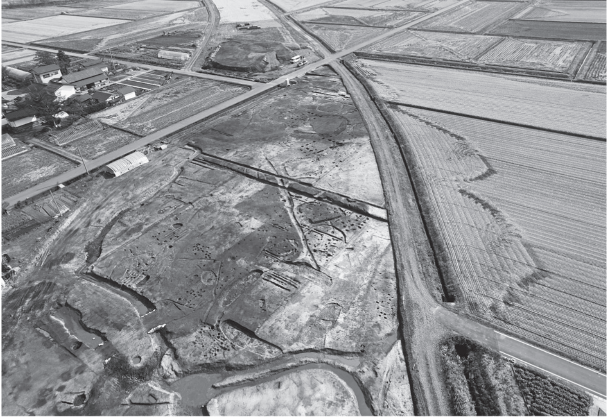
5 2次調査区全景（3）（北西から）
