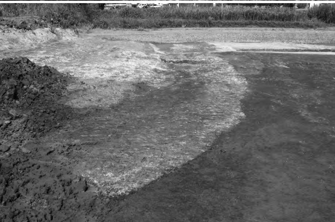
402号溝検出状態 (北西から)
