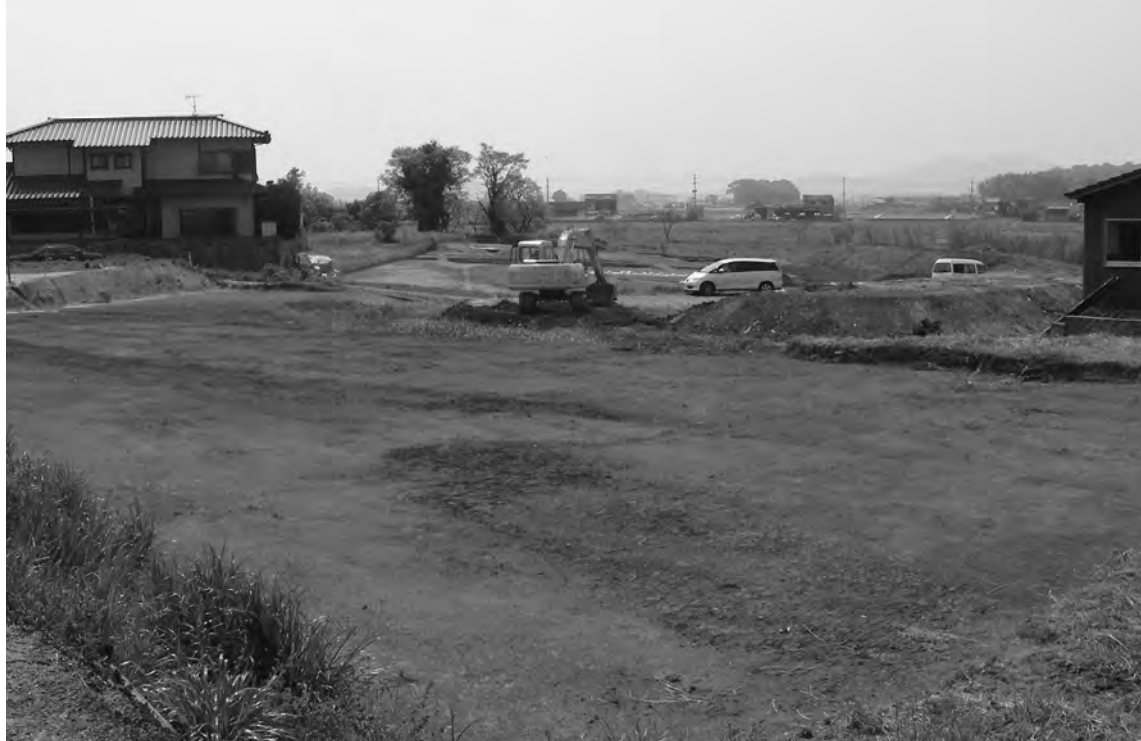
I-2区表土掘削後 (北西から)
