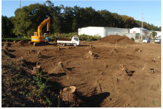
重機表土剥ぎ
