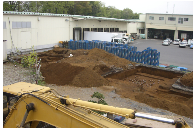
完掘（南西から）
