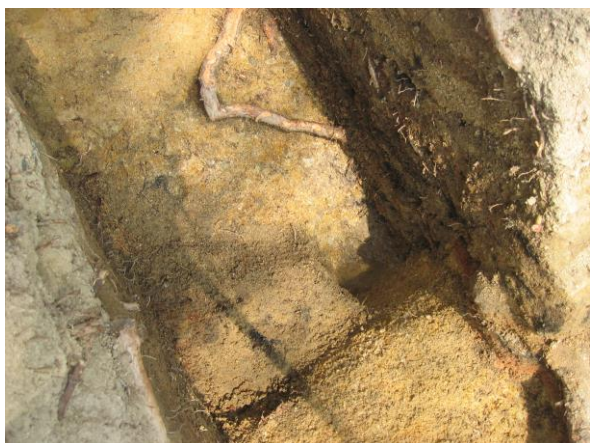
C) 縦断トレンチ溝部分 (南西より)
