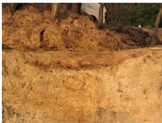
H) 満濃池浸食部分精査状況 (南より)
