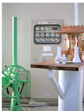
写真 15 現在の取水塔機械室内部 (2007 年 12 月 24 日撮影)
