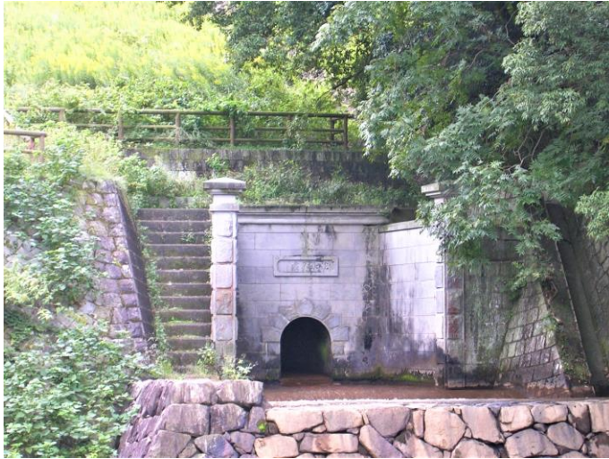
写真 23 樋門（2007年10月14日撮影）
