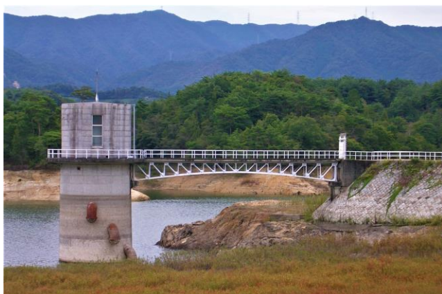
写真 14 現在の取水塔 (2008 年 1 月 2 日撮影)
