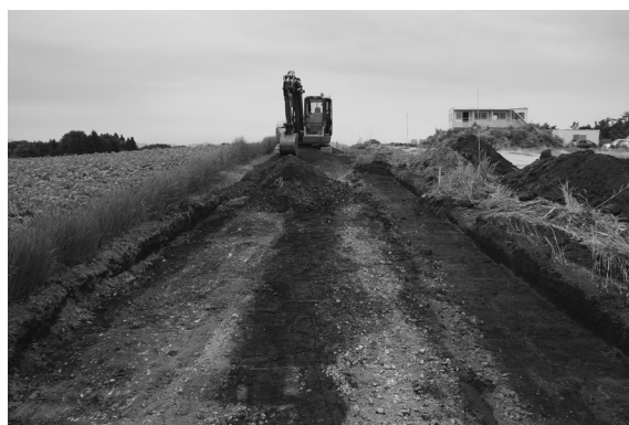
作業風景 I I-107 付近 表土除去 東から
