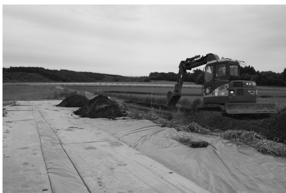
作業風景 I I-103 付近 表土除去 西から
