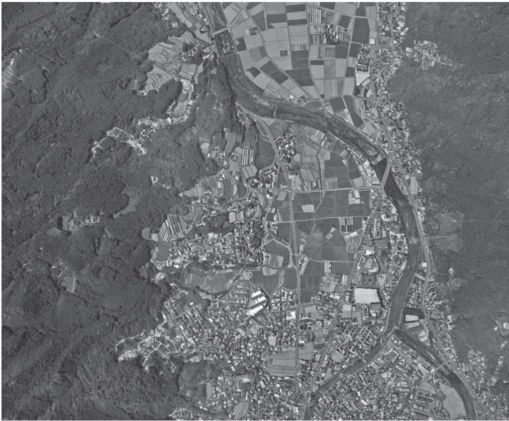
写真3 土地改良事業前（平成21年5月撮影）
