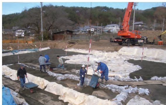
1次調査 人力と重機による埋め戻し作業
