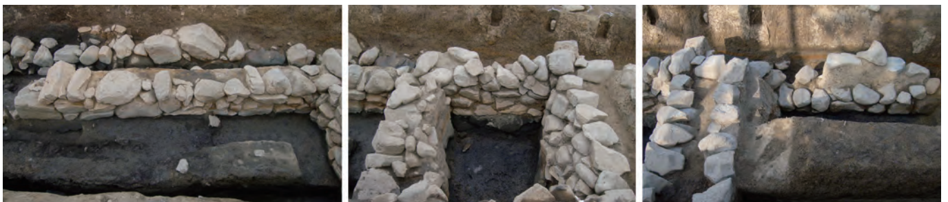
3・4面 石積B1～B3 完掘状況 (南から)
