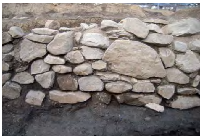
3・4面 石積A⑤ (南から)
