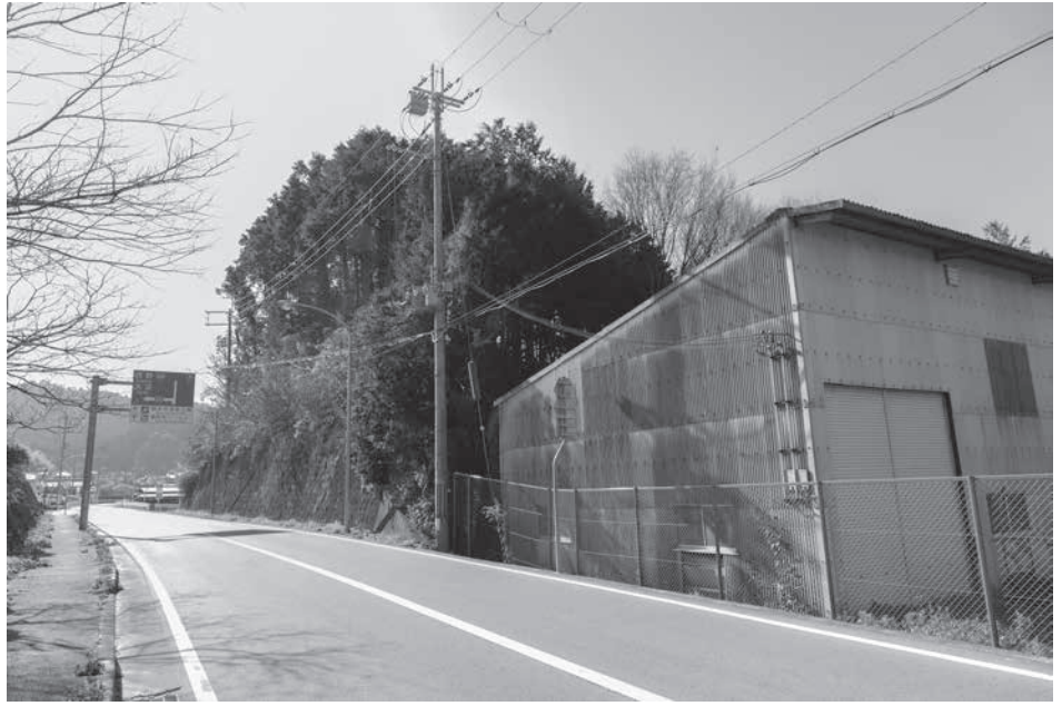
1 調査地遠景（北から）
