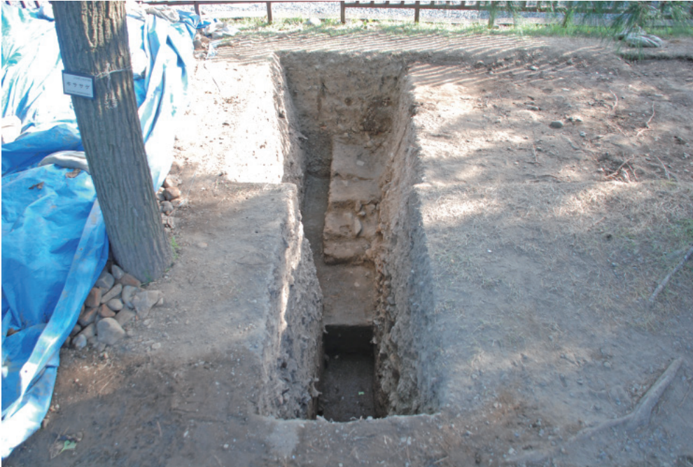
南外堀トレンチF 東側トレンチ（北から）
