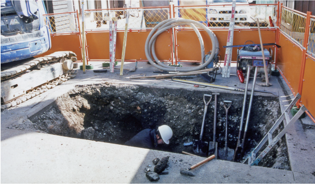
西外堀トレンチ2 全景 (北から)
