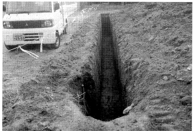
3 トレンチ完掘状況
