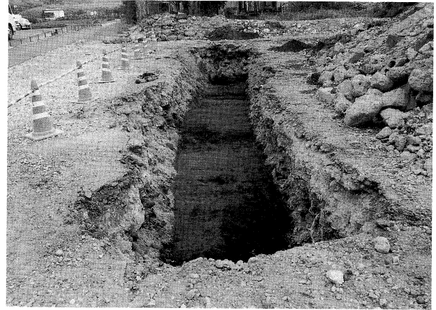
トレンチ完掘状況
