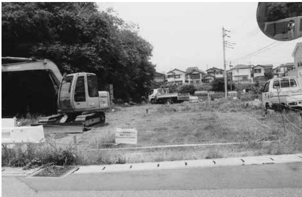
(5) m地点調査前状況
