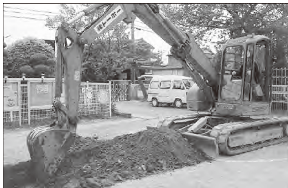
重機掘削状況
