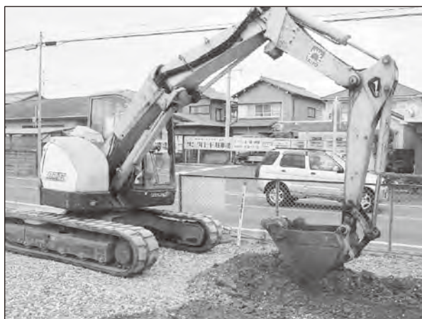
重機掘削状況
