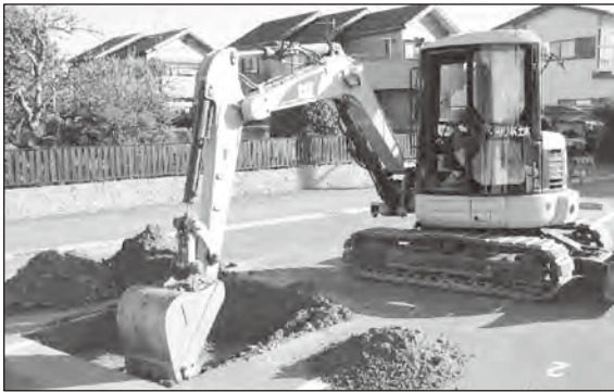
重機掘削状況
