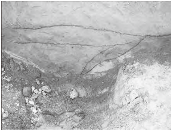
土層断面状況(試掘坑 2)
