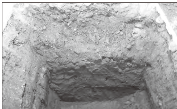
土層断面状況 (試掘坑 2)
