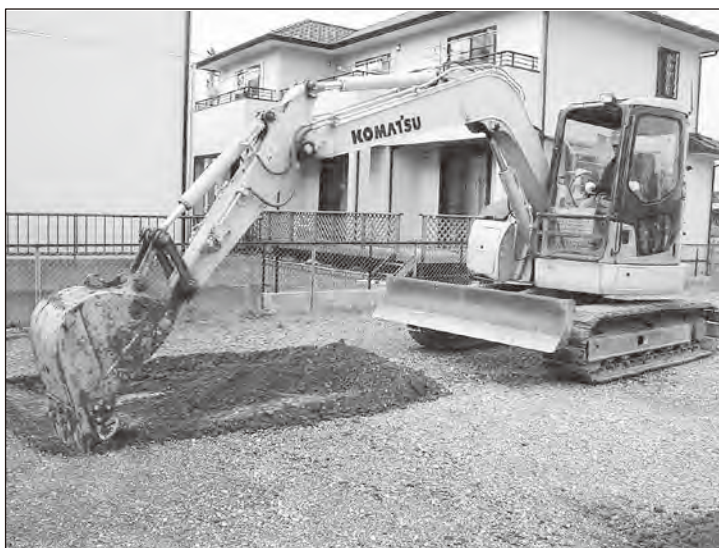
重機掘削状況
