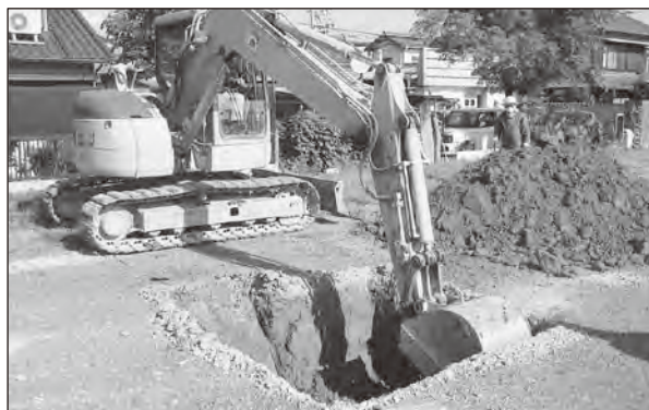
重機掘削状況
