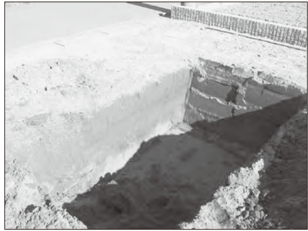
完掘状況(試掘坑 4)
