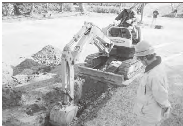
重機掘削状況
