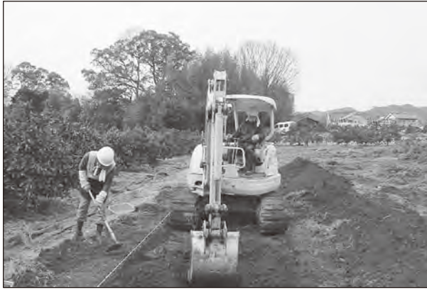
重機掘削状況
