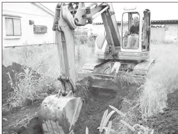
重機掘削状況
