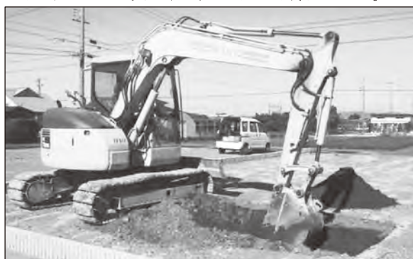
重機掘削状況
