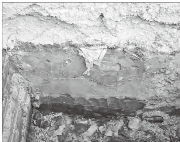
土層断面状況(試掘坑3)
