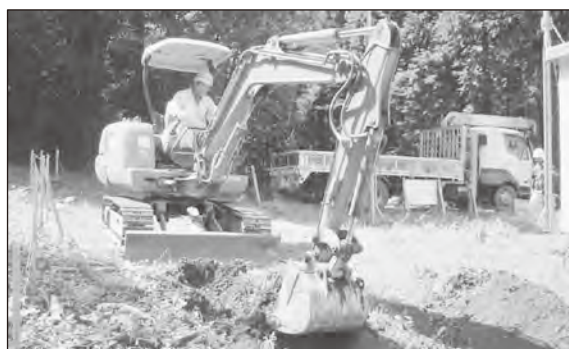
重機掘削状況
