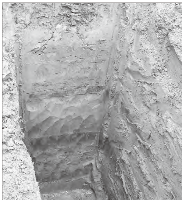
土層断面状況 (試掘坑2)
