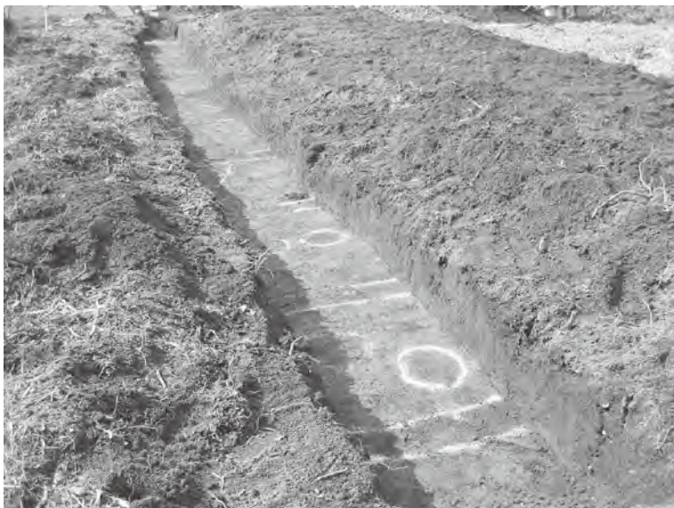
2 トレンチ完掘状況
