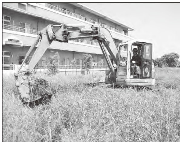
重機掘削状況
