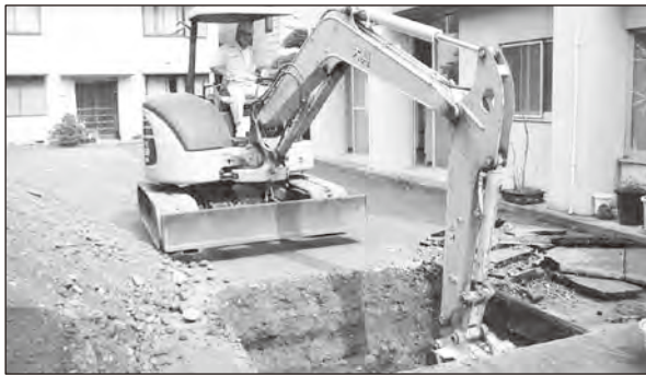
重機掘削状況
