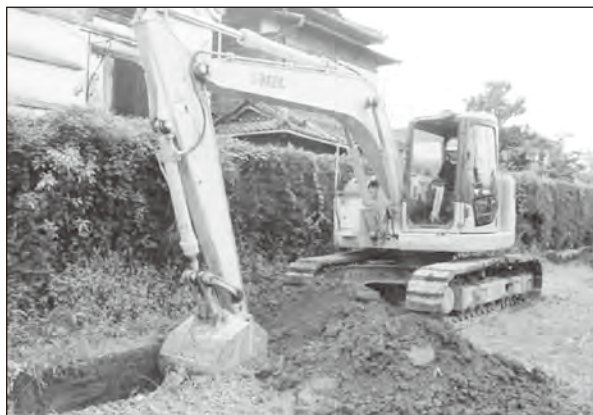
重機掘削状況
