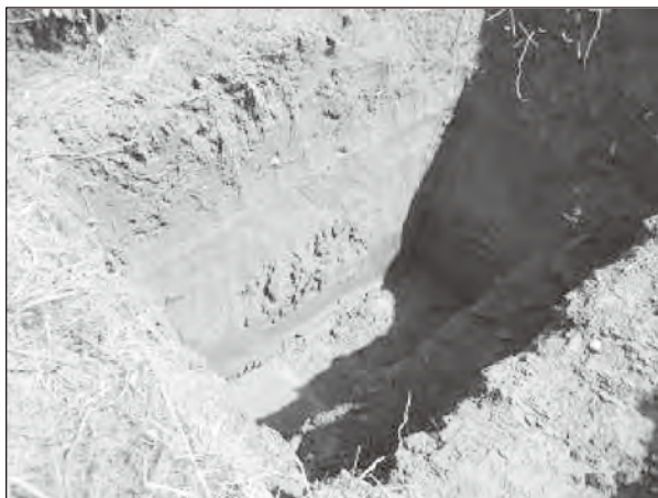
完掘状況 (試掘坑 3)
