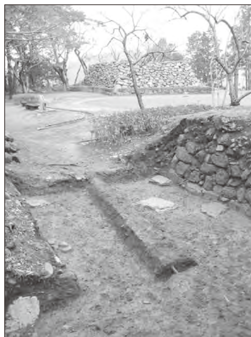
本丸中仕切門検出状況
