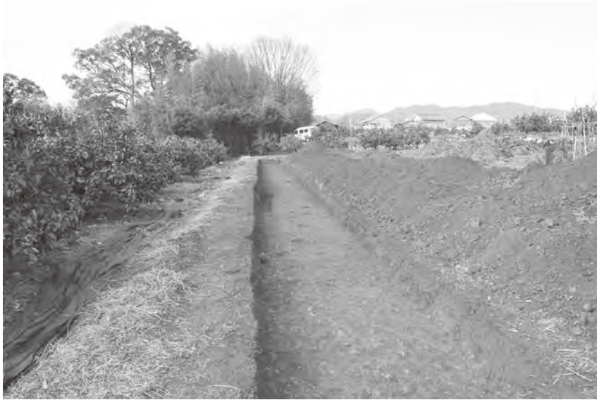
1 トレンチ完掘状況
