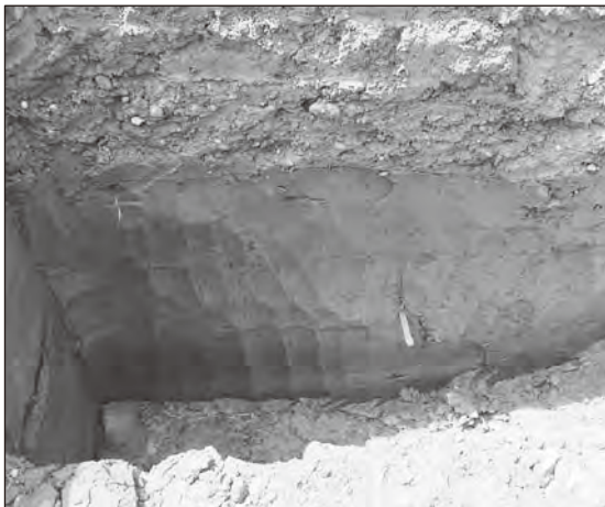
土層断面状況 (試掘坑 1)
