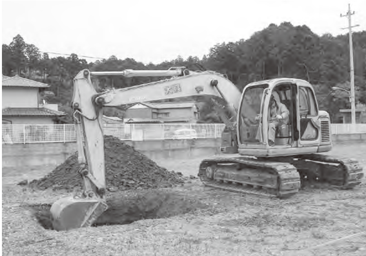
重機掘削状況
