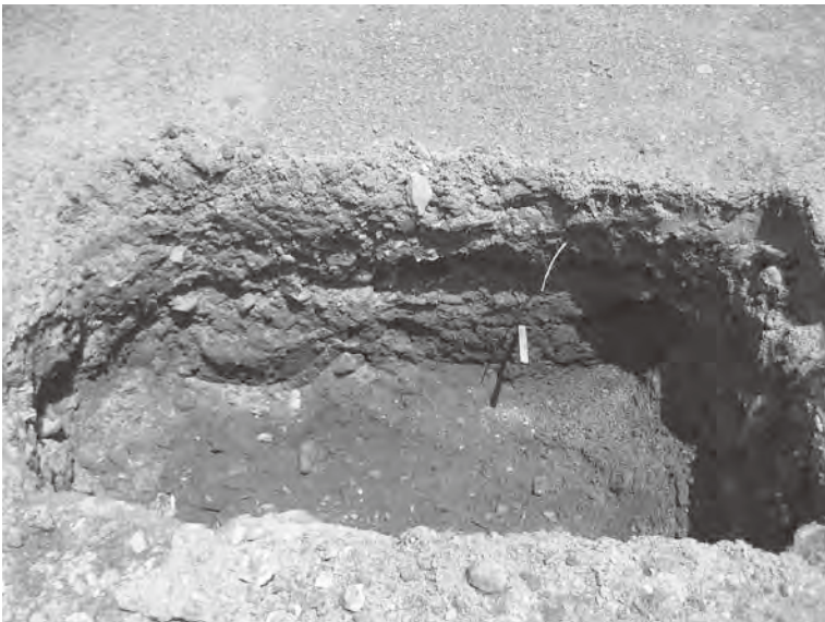
試掘坑完掘状況
