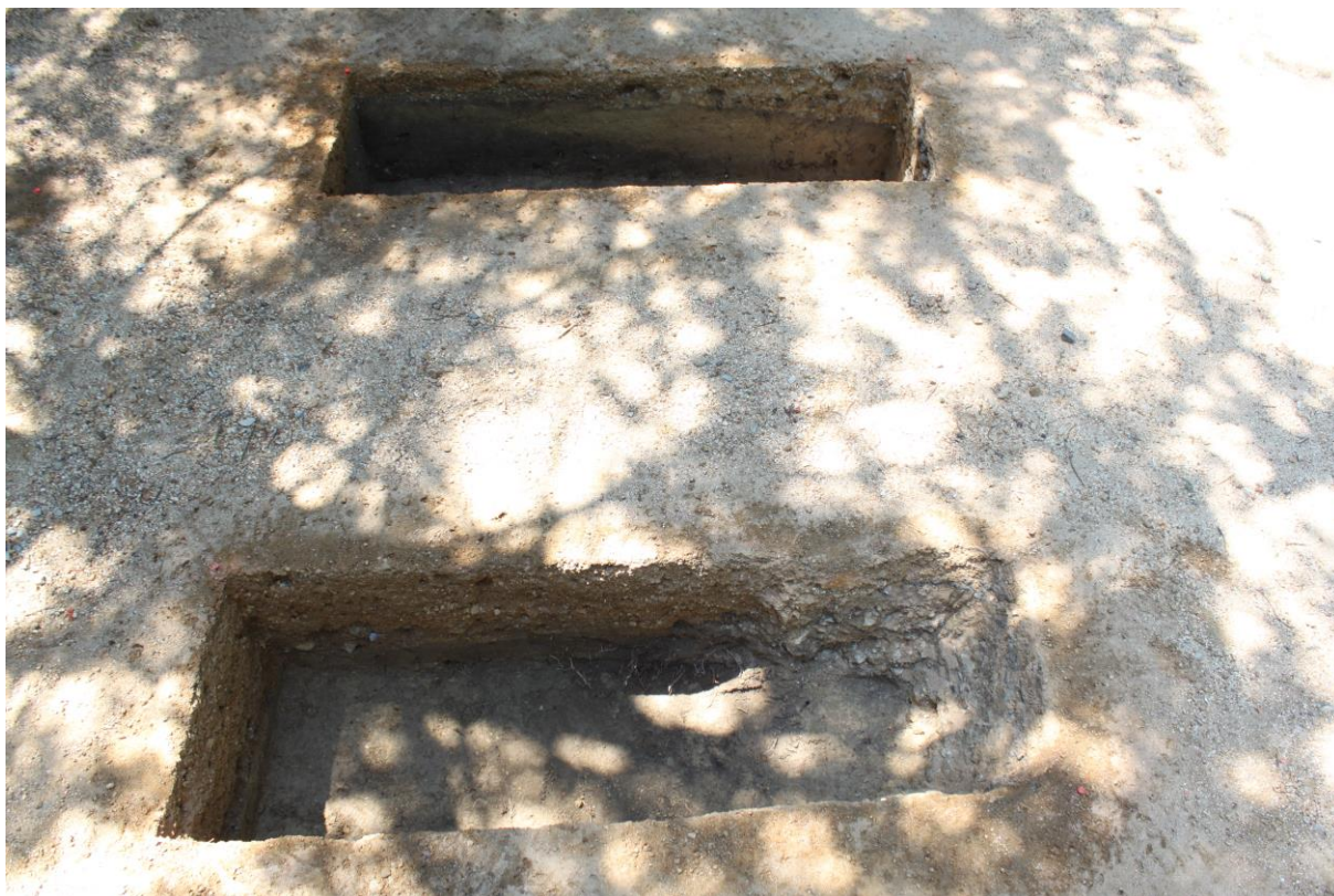
一時避難所建設予定地トレンチ 全景 南より
