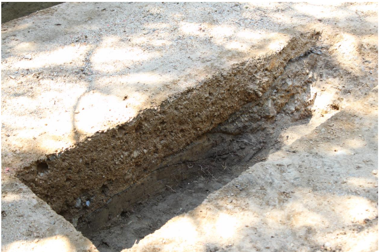
一時避難所建設予定地トレンチ2 北壁土層断面 南より
