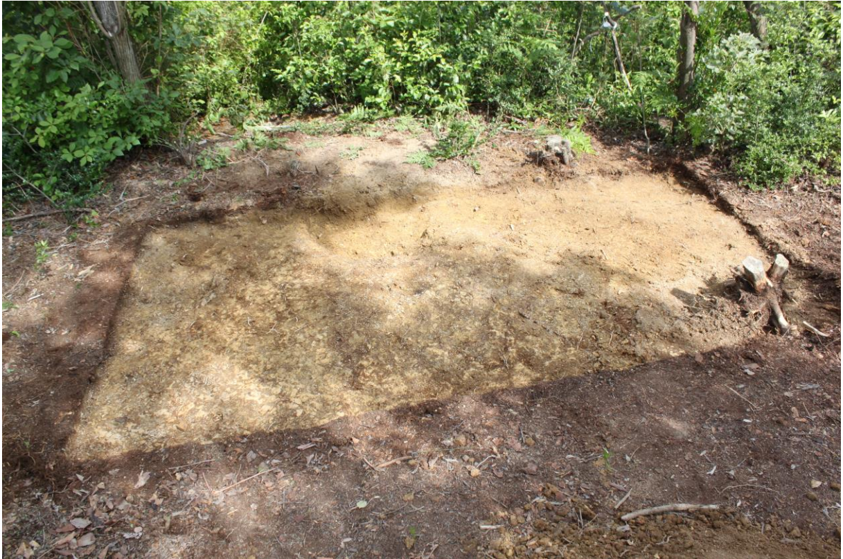
ベンチ設置予定地トレンチ 完掘状況 全景 西より
