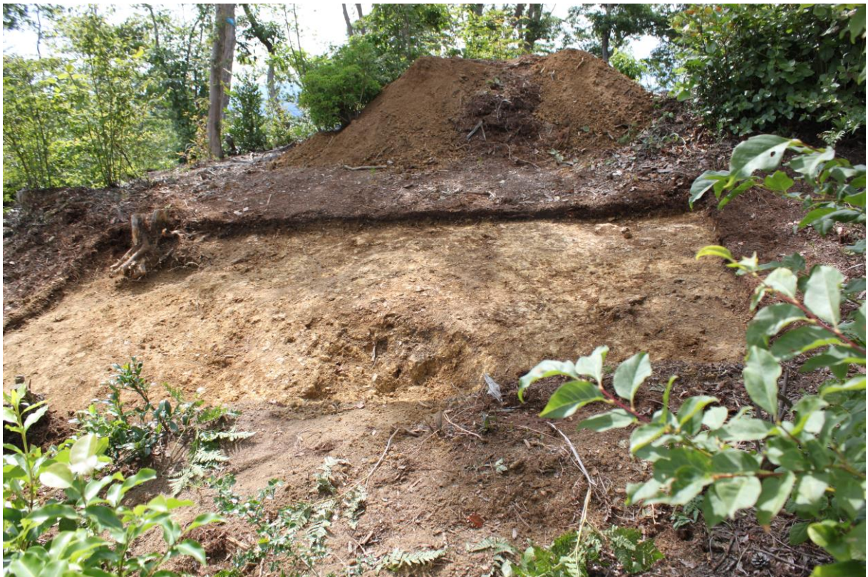
ベンチ設置予定地トレンチ 完掘状況 全景 東より
