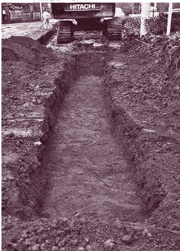
2. 2-1Tr 全景 (南東から)
