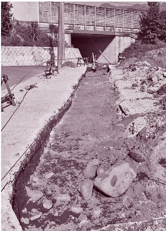
2. 1Tr 全景 (南西から)
