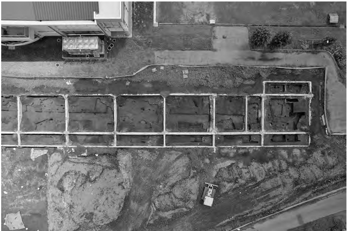
2-2 調査区南西完掘状況空撮
