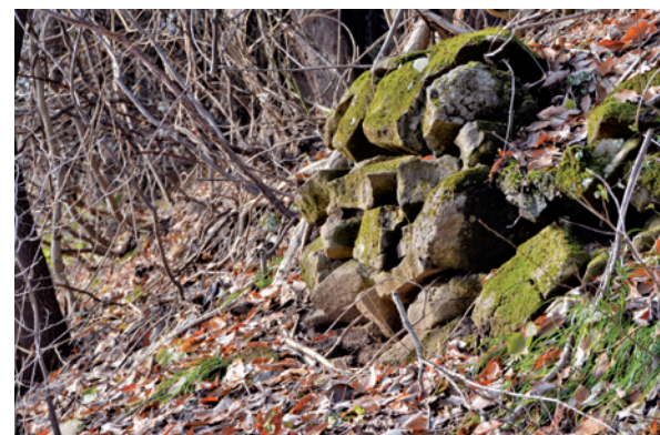
図3-24 虎口1北側の石積み 東から 左の写真と同一の石積み。急な角度で積み上げている。その分、石積みの高さは低い。
