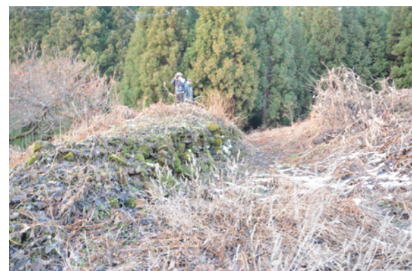
図3-49 石塁 南から 北側は高さのある石塁となる。石塁の西(左側)が曲輪5
