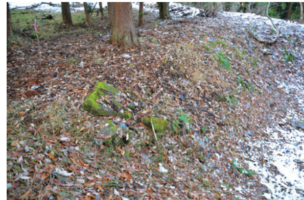
図3-12 虎口2西壁の石積 南東から 虎口2内部の壁には所々で石積みされた様子が見える。
