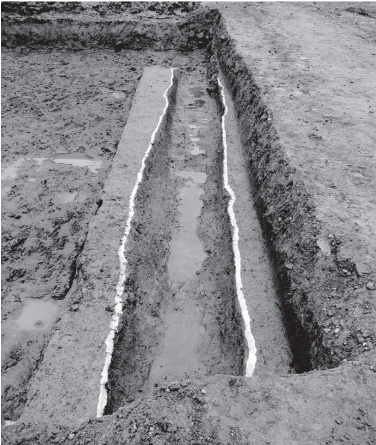
SD 1 完掘状況 (北より)
