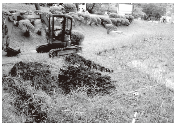
調査地全景（北西→）
