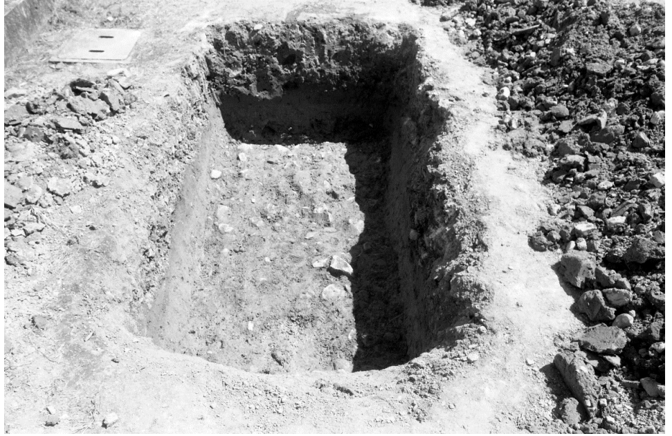
小口谷遺跡19-1区 トレンチ全景(北より)
