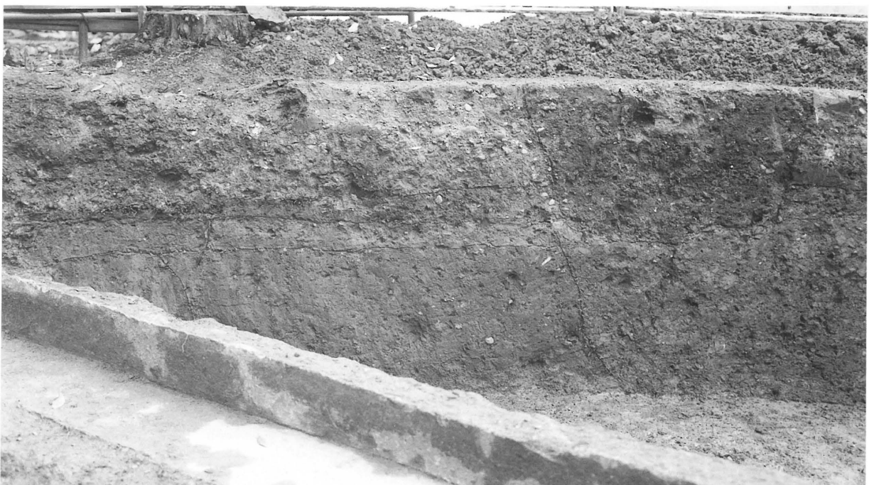
2. 調査区南壁断面 (北東から)
